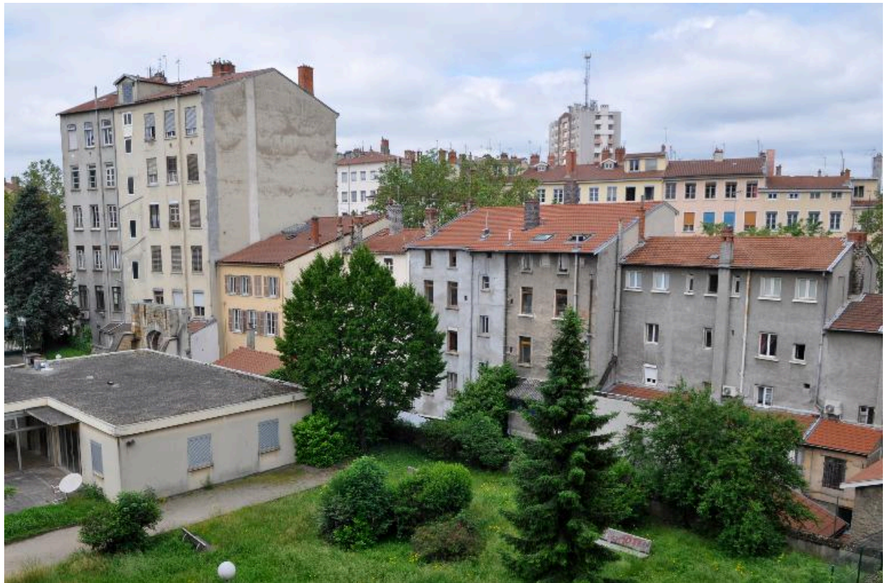
Vue des élévations postérieures des immeubles bordant la place de la Croix-Rousse (n° 17-22)
