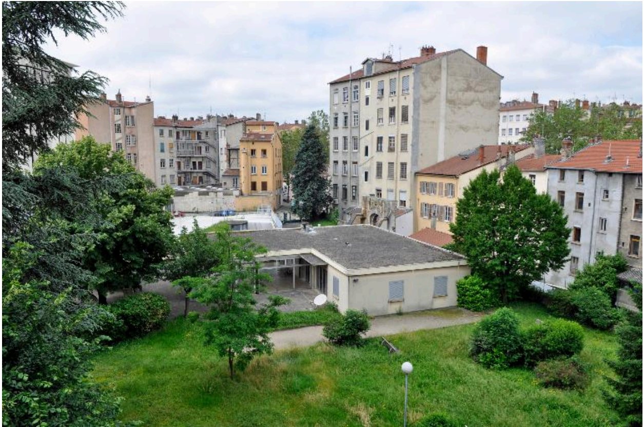
Partie ouest de l'emprise : pelouses et club-house
