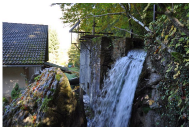
Trop plein en amont de la salle de mise en charge Phot. Samir Mahfoudi, Autr. Samir Mahfoudi IVR82_20117401358NUCA
