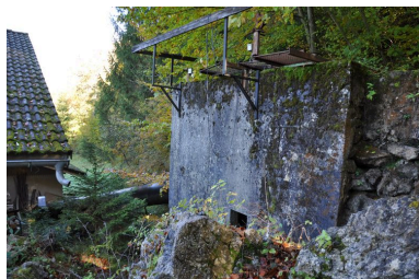
Salle de mise en charge Phot. Samir Mahfoudi, Autr. Samir Mahfoudi IVR82_20117401357NUCA
