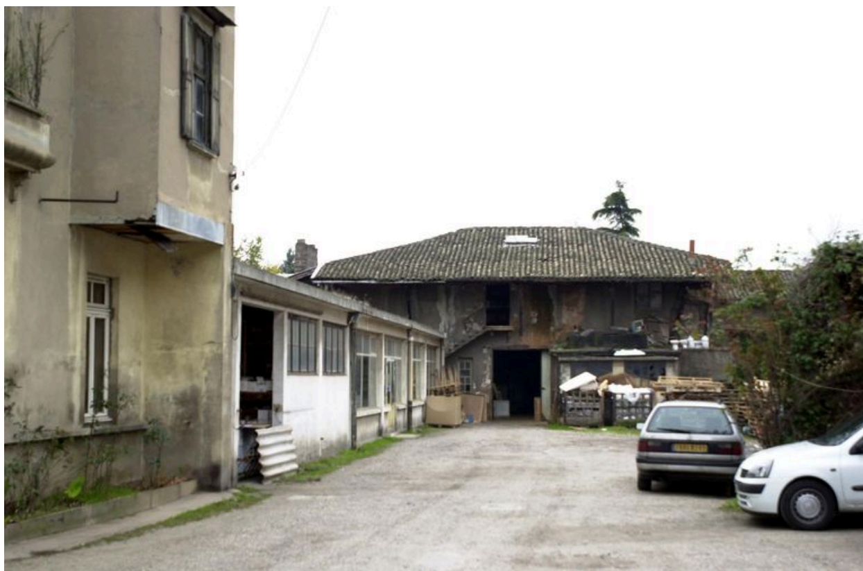
Entrepôt et ferme, façades sur cour
