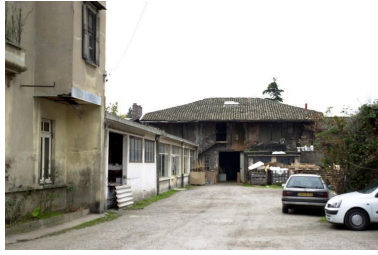
Entrepôt et ferme, façades sur cour Phot. Bernard Ducouret IVR82_20016902505NUCA
