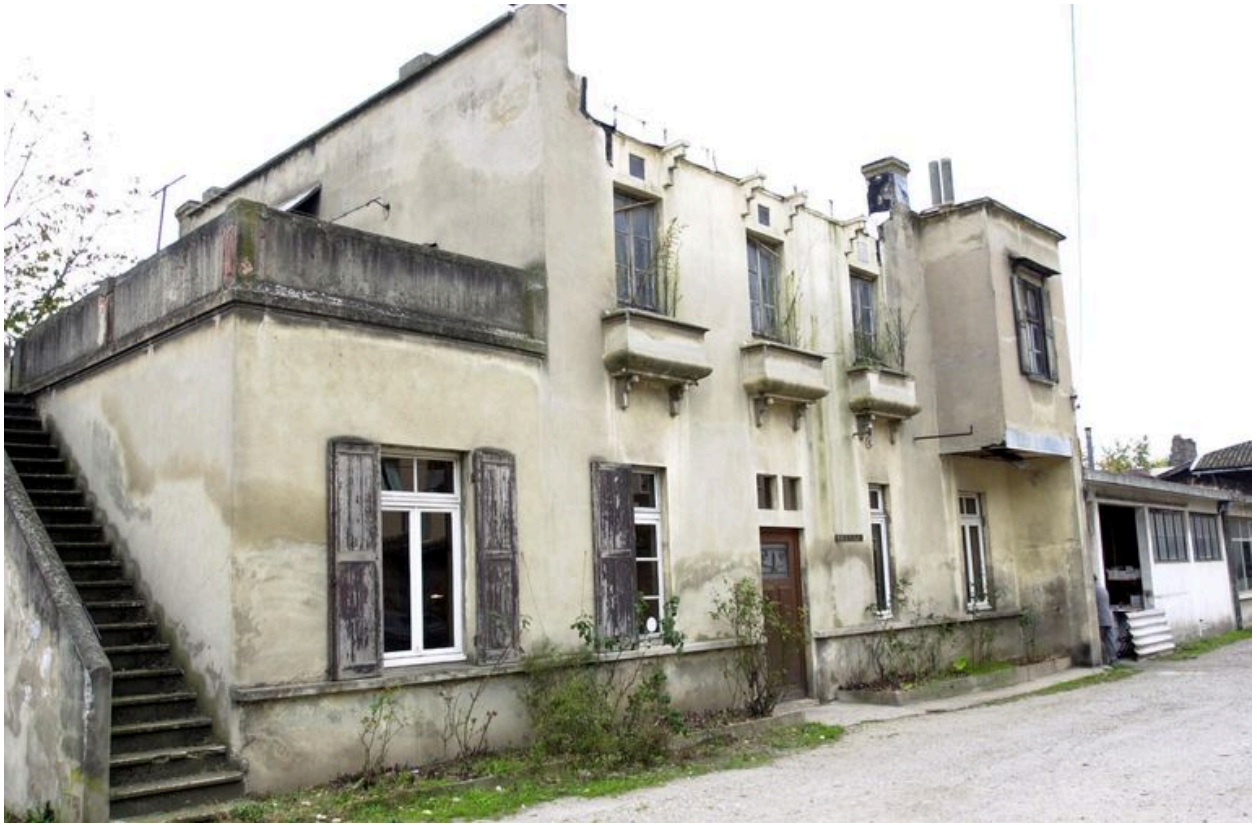
Maison, façade principale sur cour
