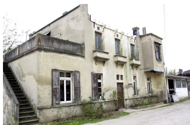
Maison, façade principale sur cour Phot. Bernard Ducouret IVR82_20016902504NUCA
