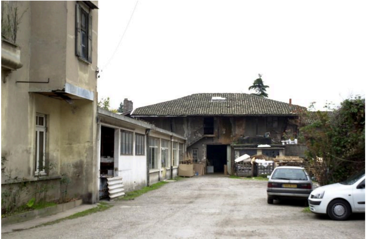
Entrepôt et ferme, façades sur cour
