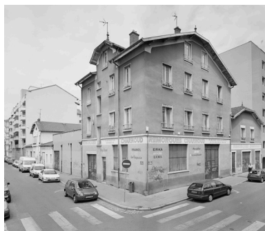
Vue générale sud-ouest du site Phot. Didier Gourbin IVR82_20066900102V
