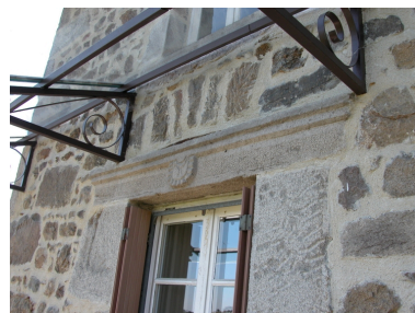
Détail du linteau de cheminée en remploi dans la façade est du logis. Phot. Thierry Monnet IVR82_20124201059NUCA
