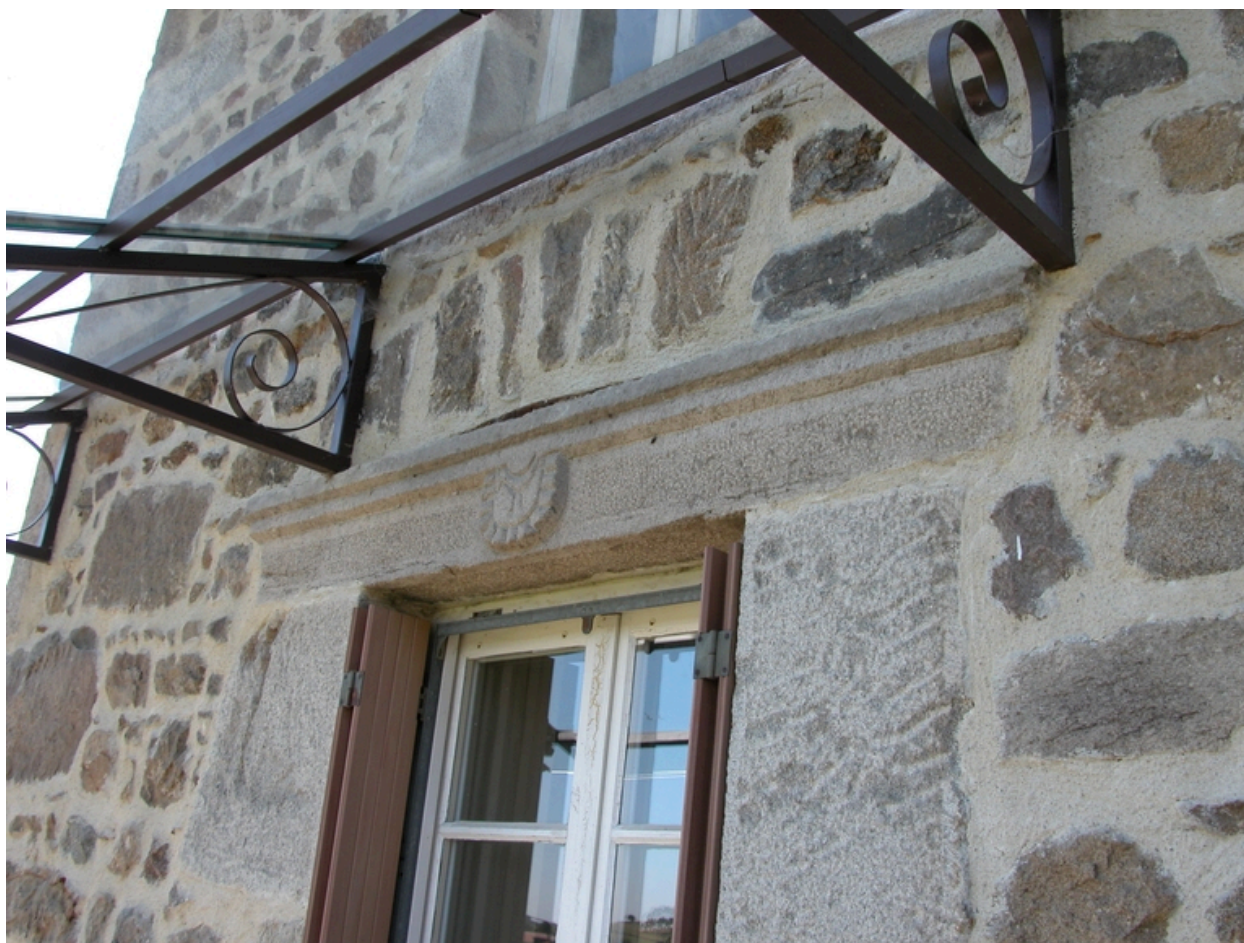
Détail du linteau de cheminée en remploi dans la façade est du logis.
