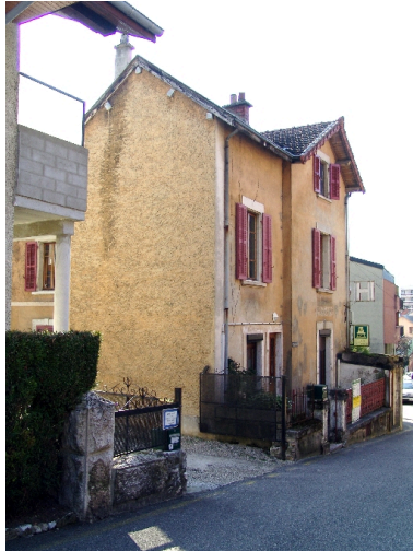
Vue de trois-quart gauche Phot. François Fouger IVR82_20097300488NUCA
