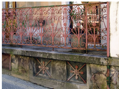
Détail du garde-corps Phot. François Fouger IVR82_20097300489NUCA
