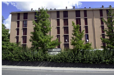
Elévation sud du bâtiment 9 donnant sur le début de la rue Simondan Phot. Véronique Belle IVR82_20056902559NUCA
