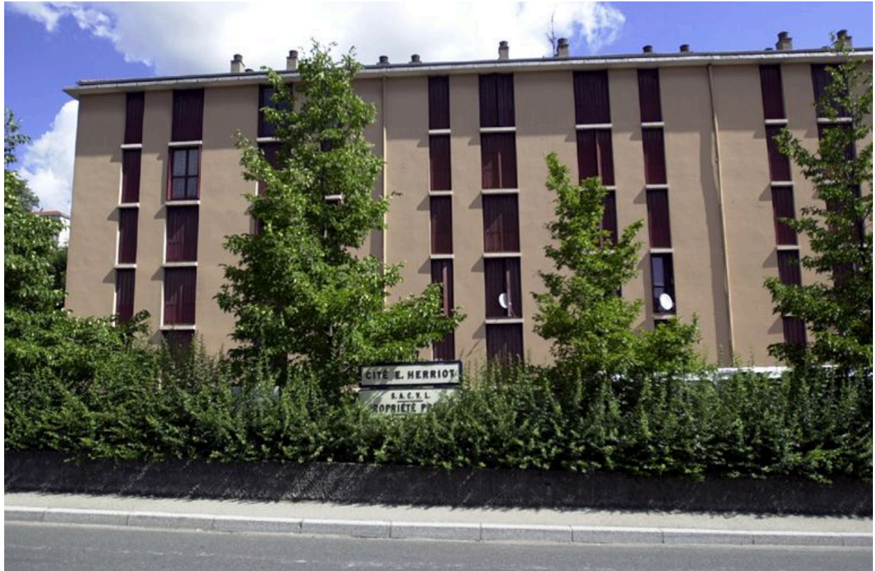
Élévation sud du bâtiment 9 donnant sur le début de la rue Simondan
