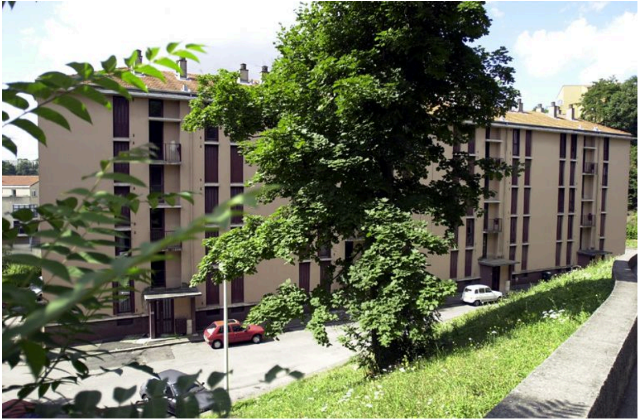
Elévation antérieure du bâtiment 9, 2-8 rue Simondan
