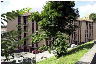
Elévation antérieure du bâtiment 9, 2-8 rue Simondan Phot. Véronique Belle IVR82_20056902560NUCA
