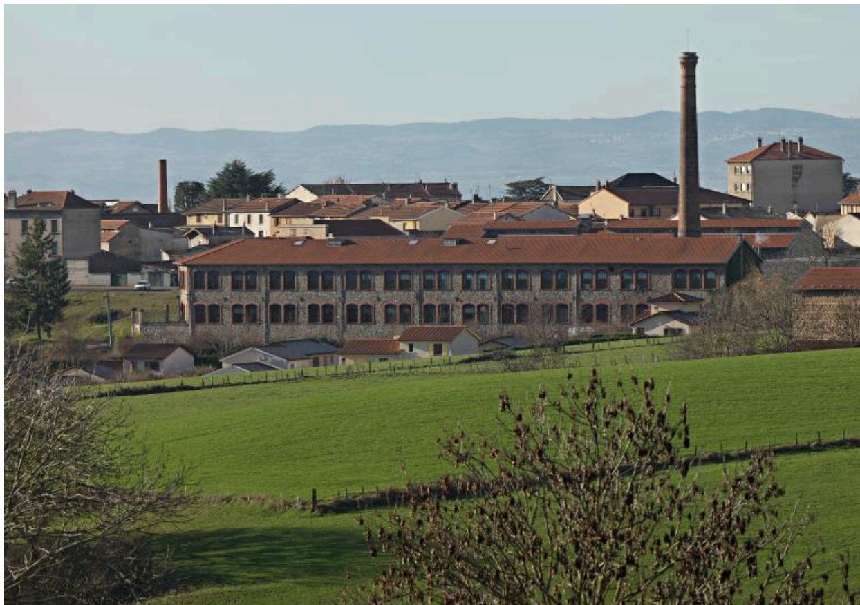
Vue des ateliers et de la cheminée.
