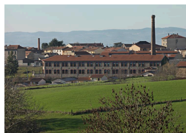
Vue des ateliers et de la cheminée. Phot. Thierry Leroy IVR84_20194200005NUCAQ
