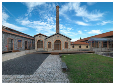
Vue du bâtiment des machines. Phot. Thierry Leroy IVR84_20194200021NUCAQ
