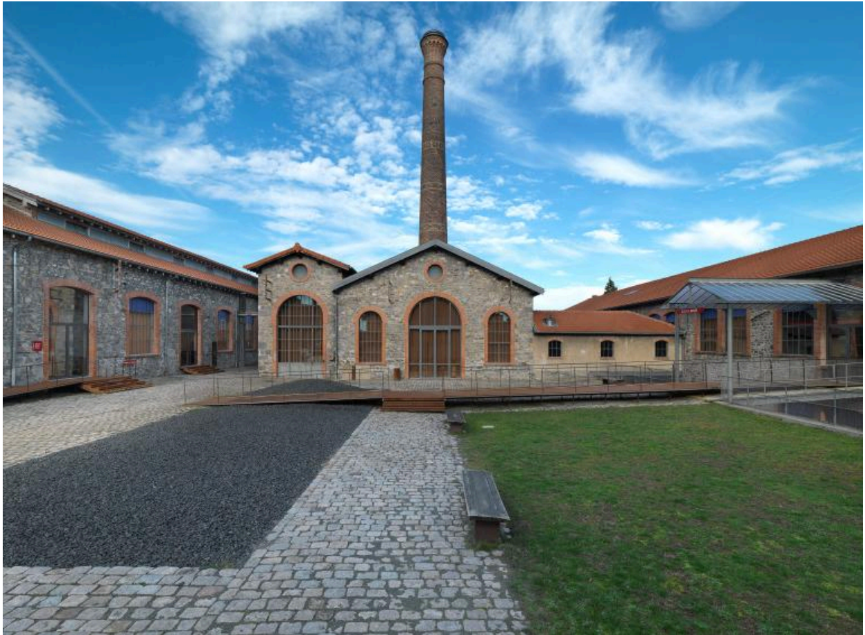
Vue du bâtiment des machines.
