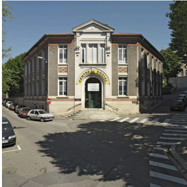
Vue générale. Phot. Eric Dessert IVR82_20064200640NUCA
