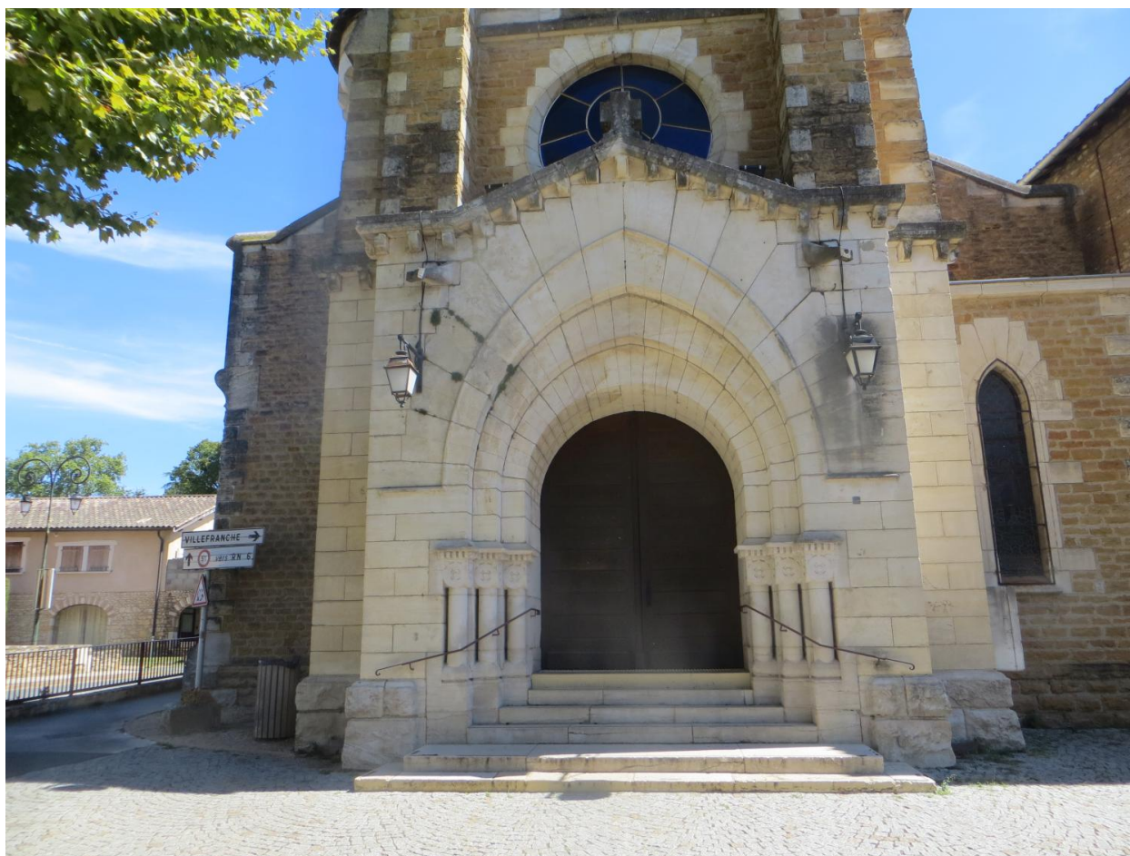
Elévation antérieure, le porche
