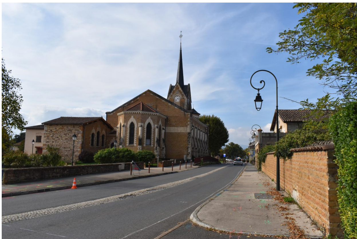
Vue de situation depuis la route de Longsard
