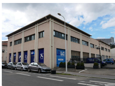
Vue ouest de l'usine Poizat
