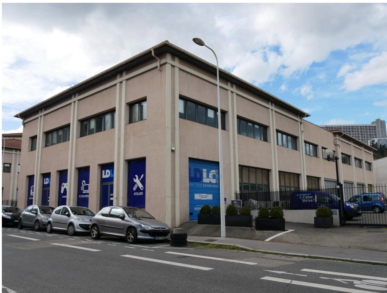
Vue ouest de l'usine Poizat
