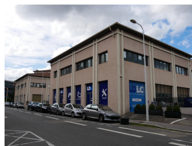
Vue d'ensemble de l'usine Poizat Phot. Nadine Halitim-Dubois IVR84_20246900112NUCA
