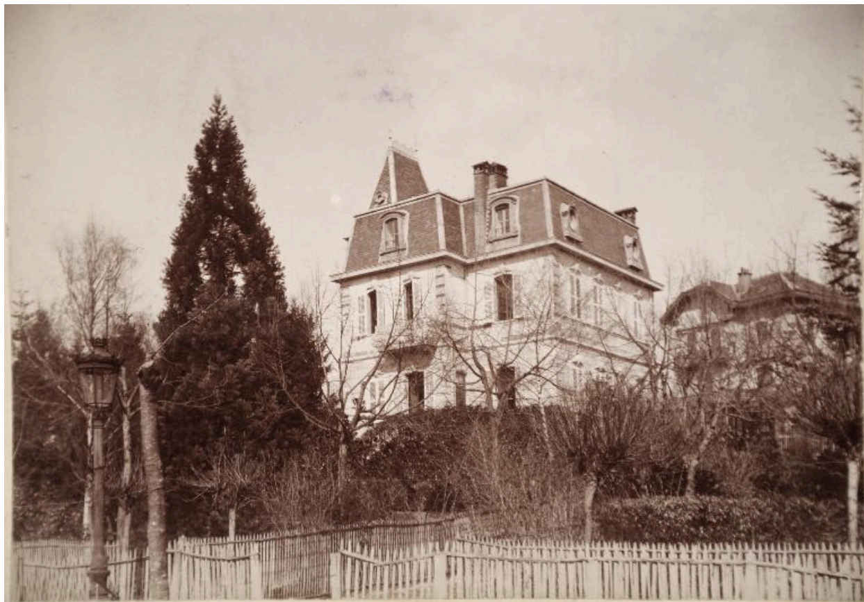
Vue générale prise depuis le sud-ouest, vers 1898
