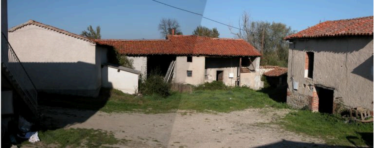
Vue générale de la ferme depuis l'intérieur de la cour.
