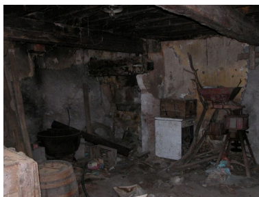
Vue partielle intérieure de la cuisine du logis. Détail de la cheminée et de l'emplacement de l'ancien four à pain.
