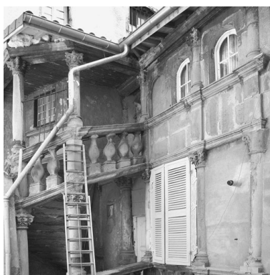
Vue partielle : 2e étage sur cour. Etage attique avec garde-corps à balustres remplacé par une allège en pierre de taille. Phot. Didier Gourbin IVR82_20064202533NUC
