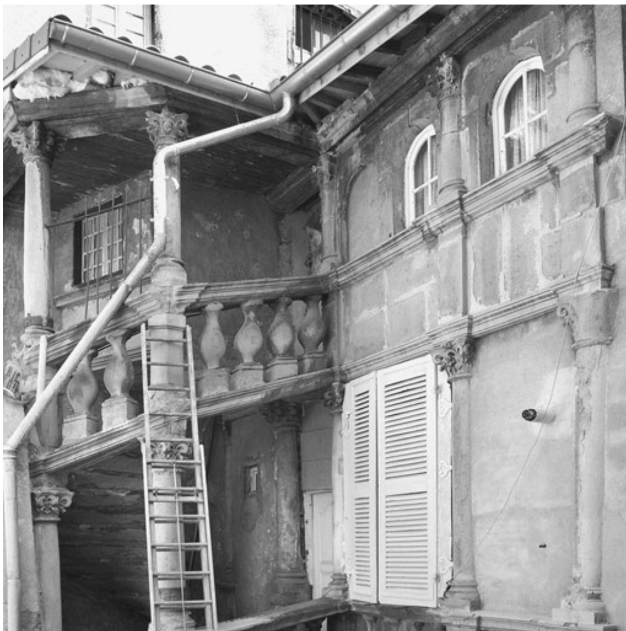
Vue partielle : 2e étage sur cour. Etage attique avec garde-corps à balustres remplacé par une allège en pierre de taille.
