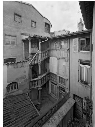
Vue générale sur cour : élévation architecturée et escalier hors oeuvre Phot. Eric Dessert IVR82_20064200469V
