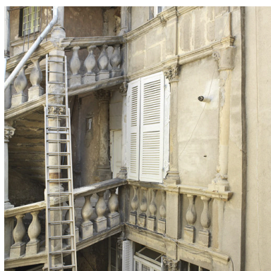
Vue partielle : 1er étage sur cour. Ancienne galerie haute ouverte. Phot. Didier Gourbin IVR82_20064202532NUCA
