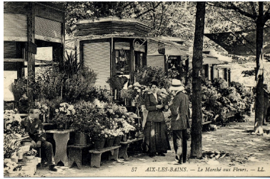
Vue générale Repro. François Fouger IVR82_20057300628NUCB
