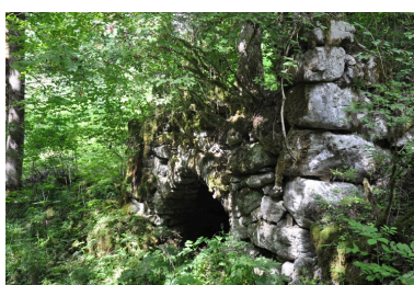
Vue générale des vestiges du moulin de Saint-Même Phot. Yannick Milleret IVR82_20107300609NUCA
