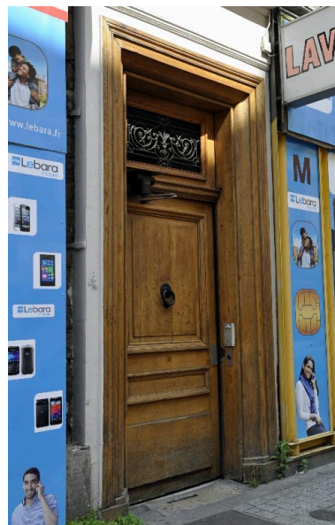
Elévation sur la rue de Marseille : porte piétonne Phot. Catherine Guégan IVR82_20156901080NUCA
