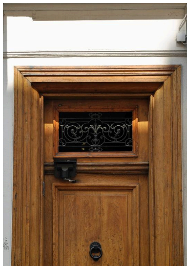
Détail de la porte : imposte en ferronnerie Phot. Catherine Guégan IVR82_20156901081NUCA
