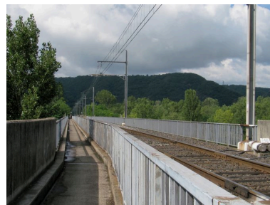
Voie piétonne et voie ferroviaire (depuis la rive gauche) Phot. I. Havard IVR82_20103800065NUCA
