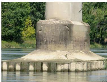
Soubassement d'une pile (depuis la rive gauche, face aval) Phot. I. Havard IVR82_20103800064NUCA
