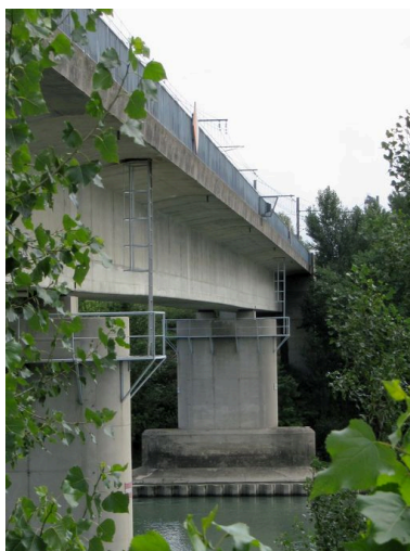
Tablier, vue partielle (depuis la rive droite, face aval) Phot. I. Havard IVR82_20103800060NUCA
