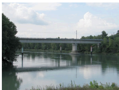
Vue générale, face amont (depuis la rive gauche) Phot. I. Havard IVR82_20103800061NUCA
