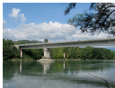
Vue générale, face aval (depuis la rive gauche) Phot. I. Havard IVR82_20103800062NUCA
