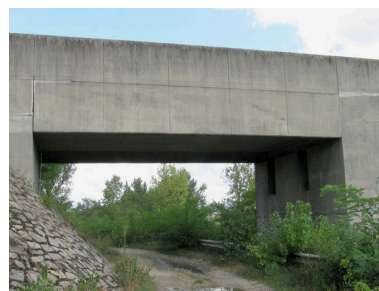
Pont-cadre, formant culée passante, rive droite, face aval Phot. I. Havard IVR82_20103800059NUCA
