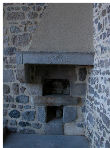
Vue de la cheminée avec four à pain. Phot. Caroline Guibaud IVR82_20124202265NUCA
