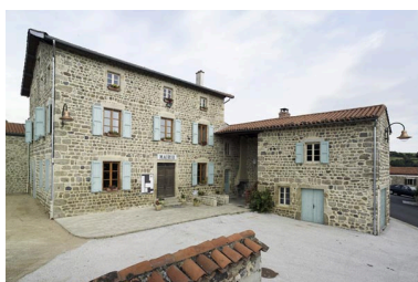
Vue générale. Phot. Didier Gourbin IVR82_20074200127NUCAQ
