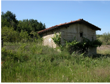
Vue générale. Phot. Thierry Monnet IVR82_20134200810NUCA
