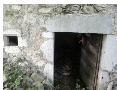
Vue d'une porte de cave en contrebas du chemin. Phot. Jérôme Daviet IVR82_20157401764NUCA
