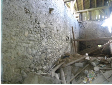
Vue d'une pièce intérieure Phot. Jérôme Daviet IVR82_20157401765NUCA
