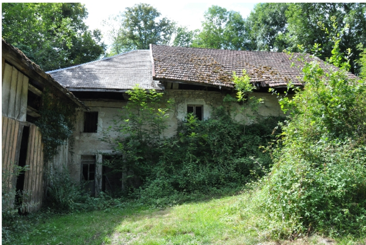
Vue générale du bâtiment, aile ouest
