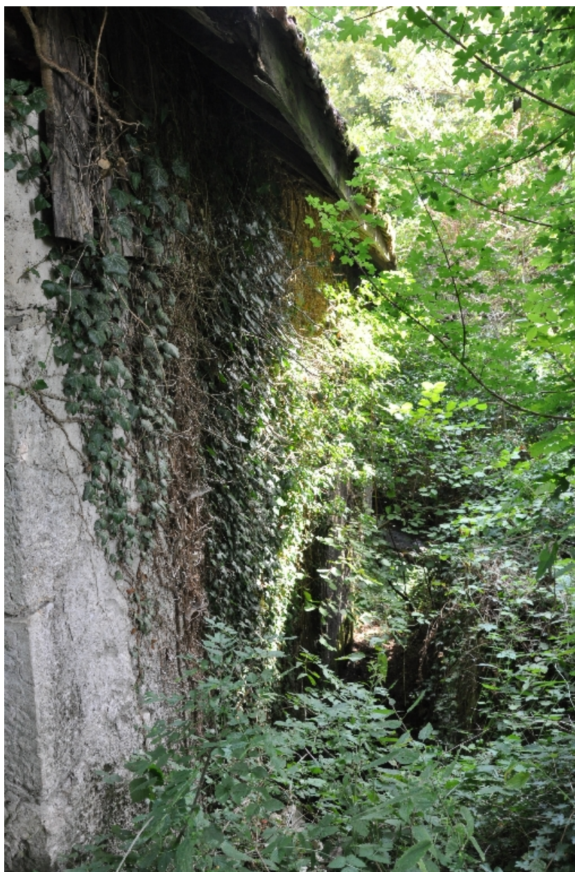
Vue de la façade nord de l'aile ouest où se trouvait la roue
