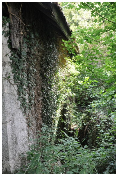
Vue de la façade nord de l'aile ouest où se trouvait la roue Phot. Yannick Milleret IVR82_20117302132NUCA
