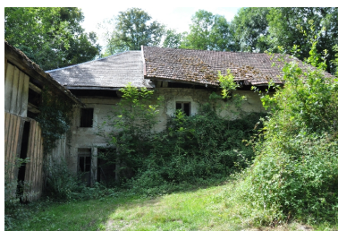
Vue générale du bâtiment, aile ouest Phot. Yannick Milleret IVR82_20117302130NUCA
