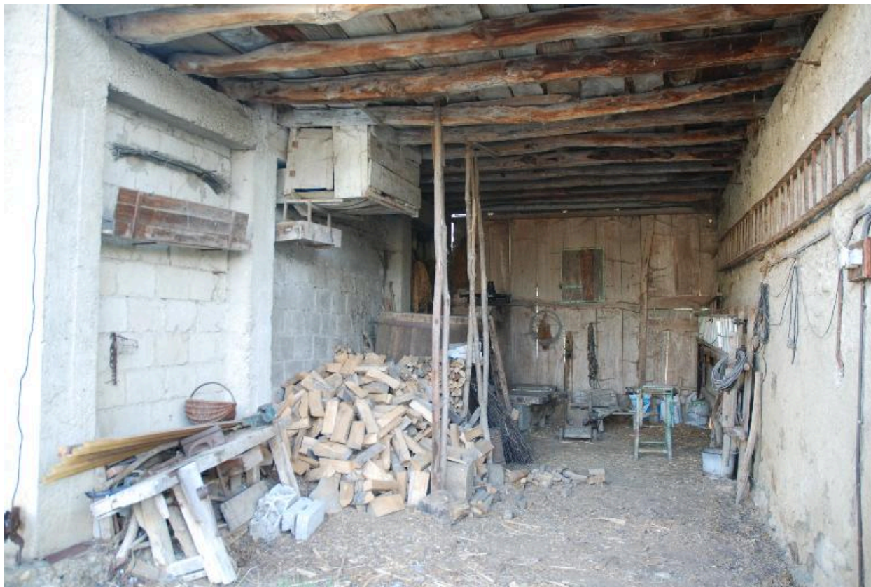
Vue intérieure de la remise.
