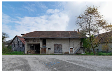
Vue générale. Phot. Eric Dessert IVR84_20167306648NUCA
