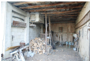
Vue intérieure de la remise. Phot. Thierry Monnet IVR84_20177301317NUCA
