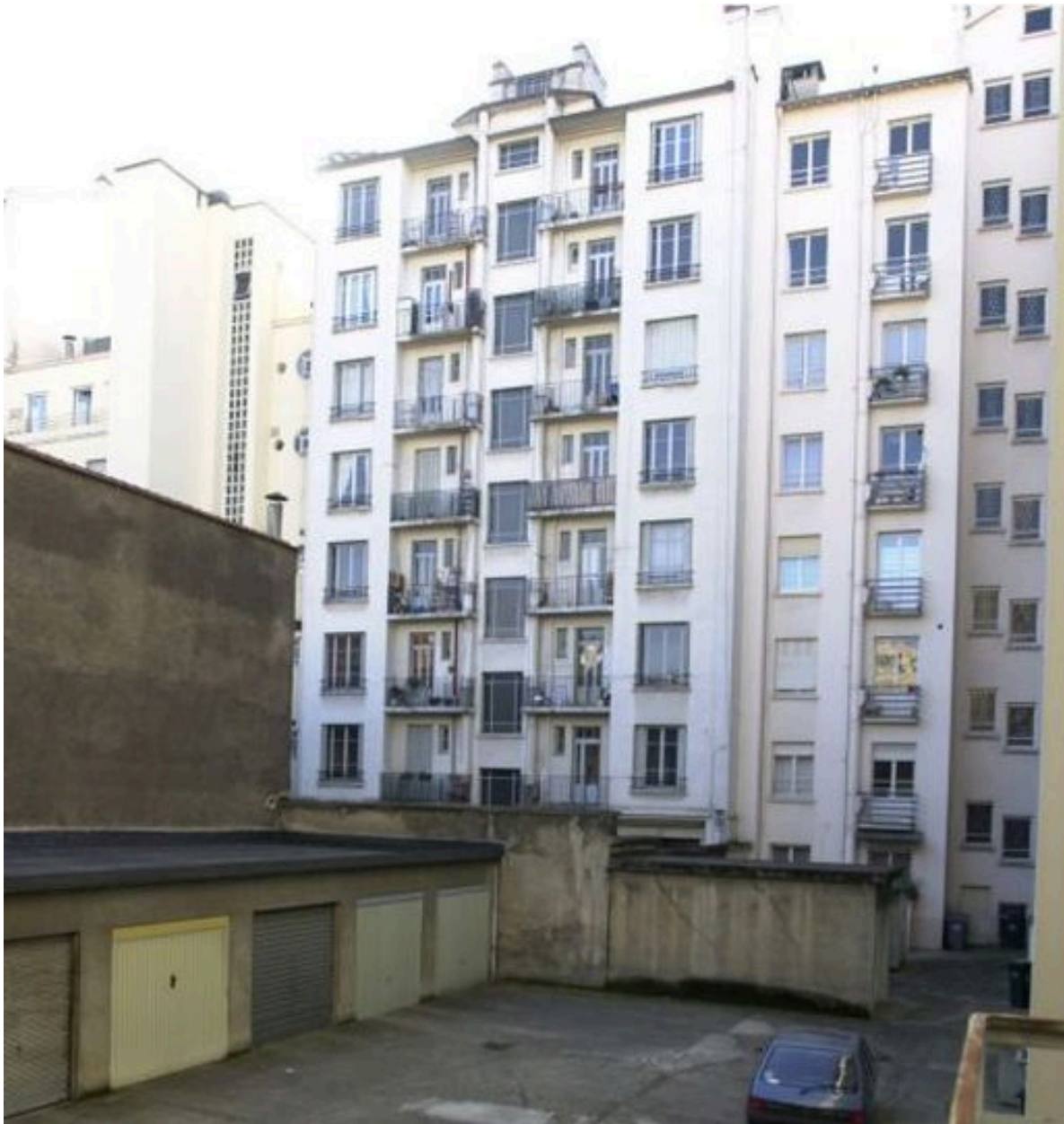
Vue générale de l'élévation postérieure sur cour et des garages
