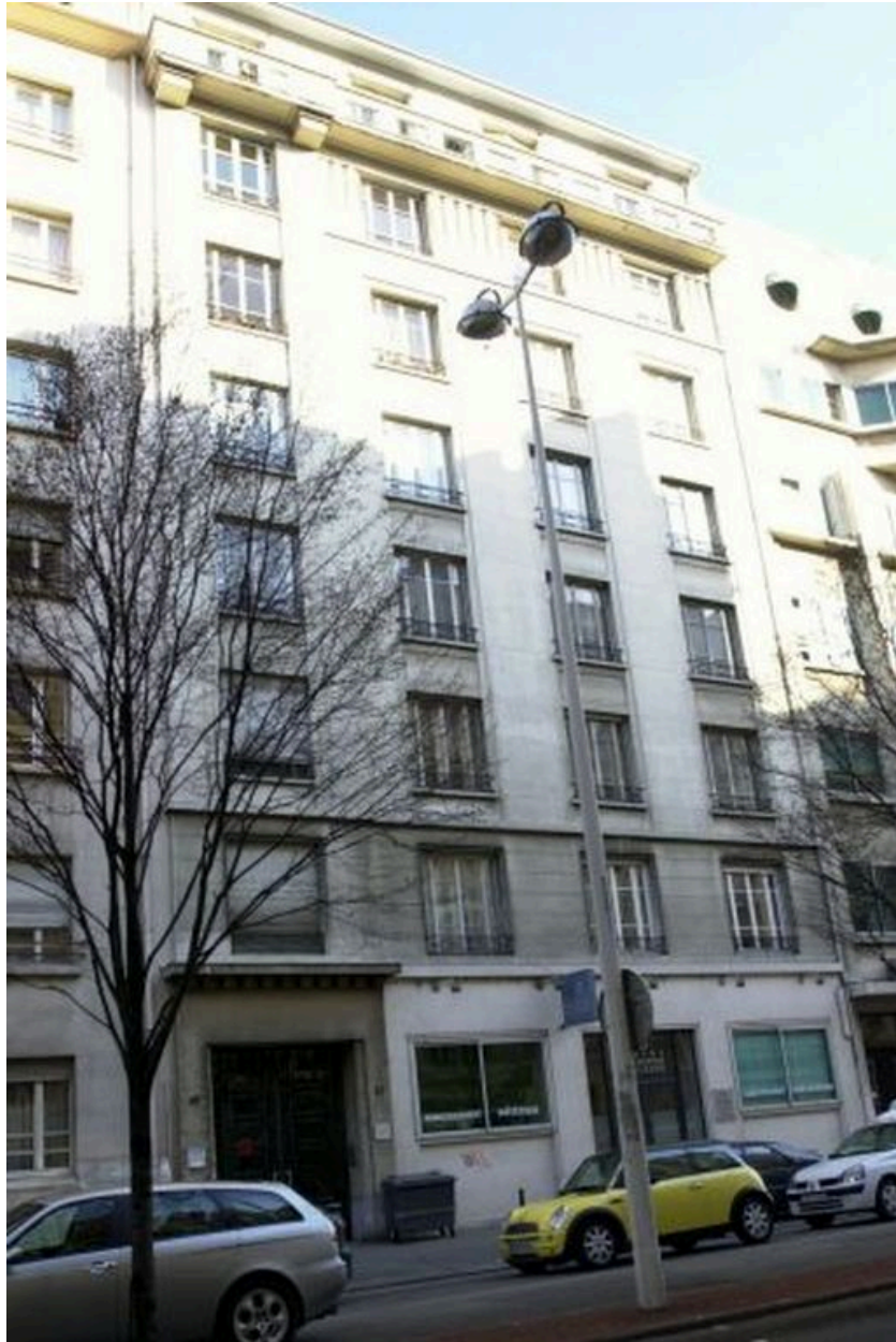
Vue générale de l'élévation sur rue
