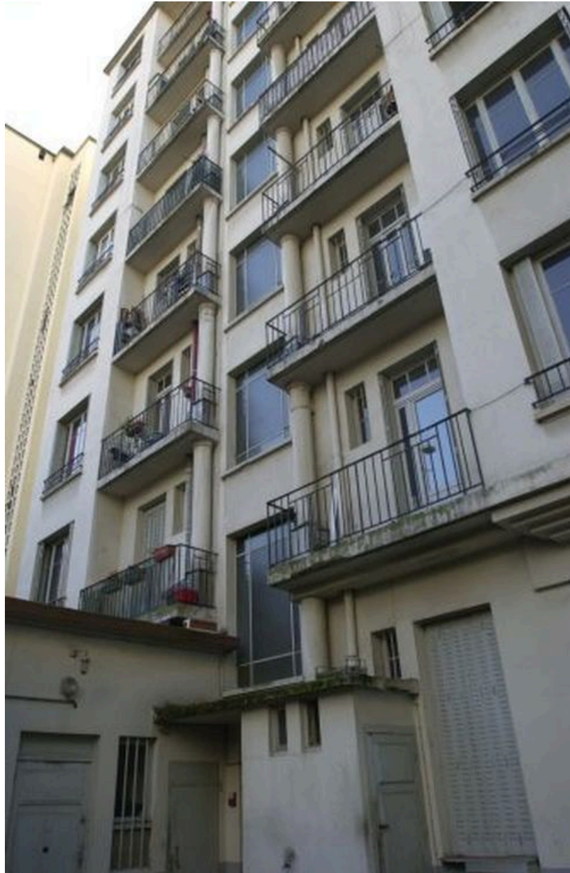
Vue rapprochée de la façade postérieure
