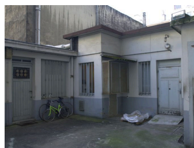
Loge de concierge dans la cour Phot. Maryannick Chalabi IVR82_20046903116NUCA
