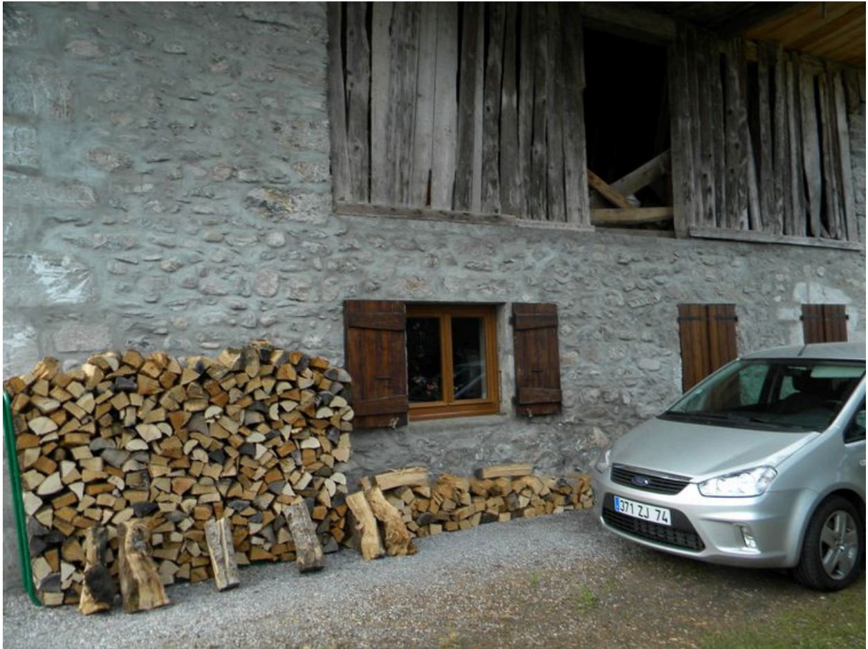
Vue partielle de la façade nord.
