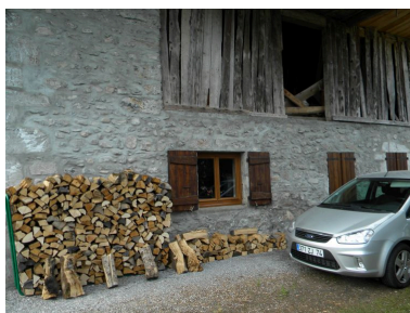
Vue partielle de la façade nord. Phot. Jérôme Daviet IVR82_20107402727NUCA
