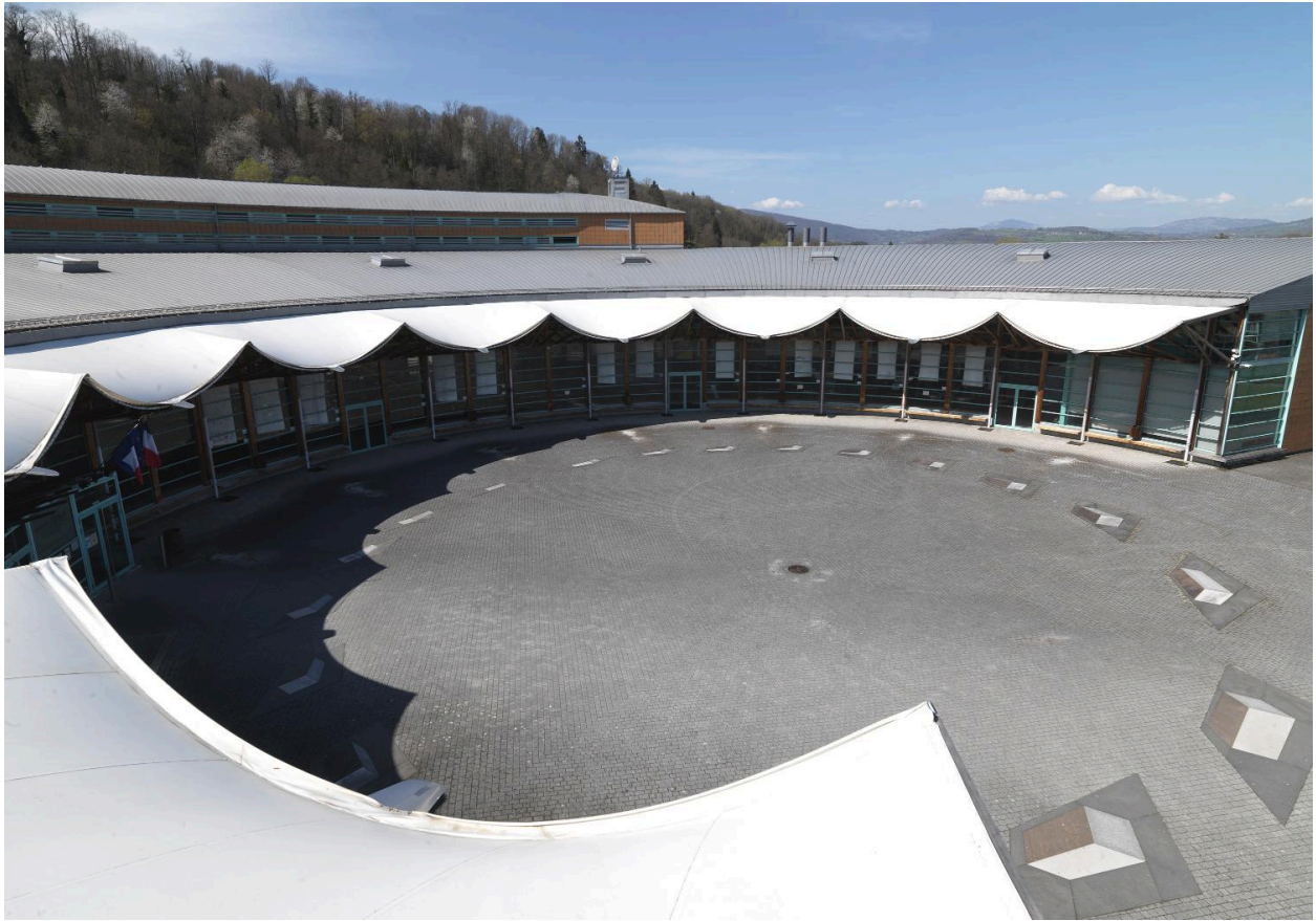
Vue d'ensemble, depuis le toit.
