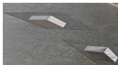
Vue rapprochée, en 2021. Phot. Franck Trabouillet IVR84_20217400327NUCA
