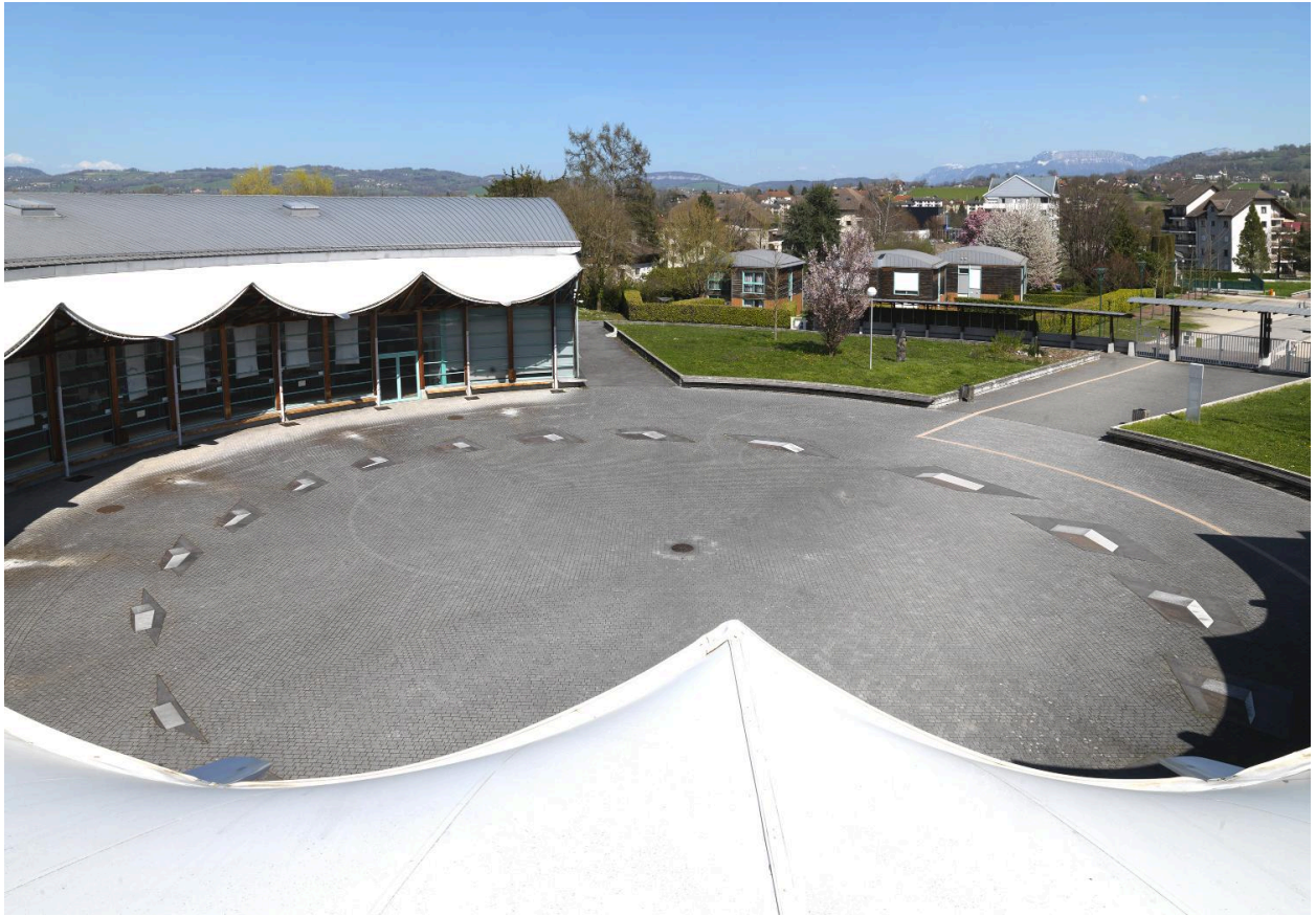
Vue d'ensemble, depuis le toit.
