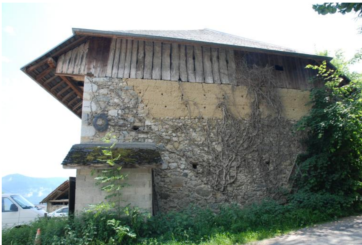
Vue du mur pignon nord.
