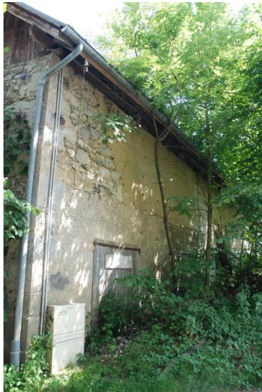
Vue arrière. Phot. Thierry Monnet IVR84_20207400241NUCA
