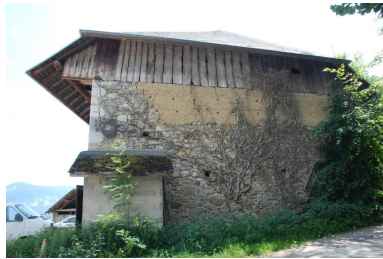
Vue du mur pignon nord. Phot. Thierry Monnet IVR84_20207400240NUCA
