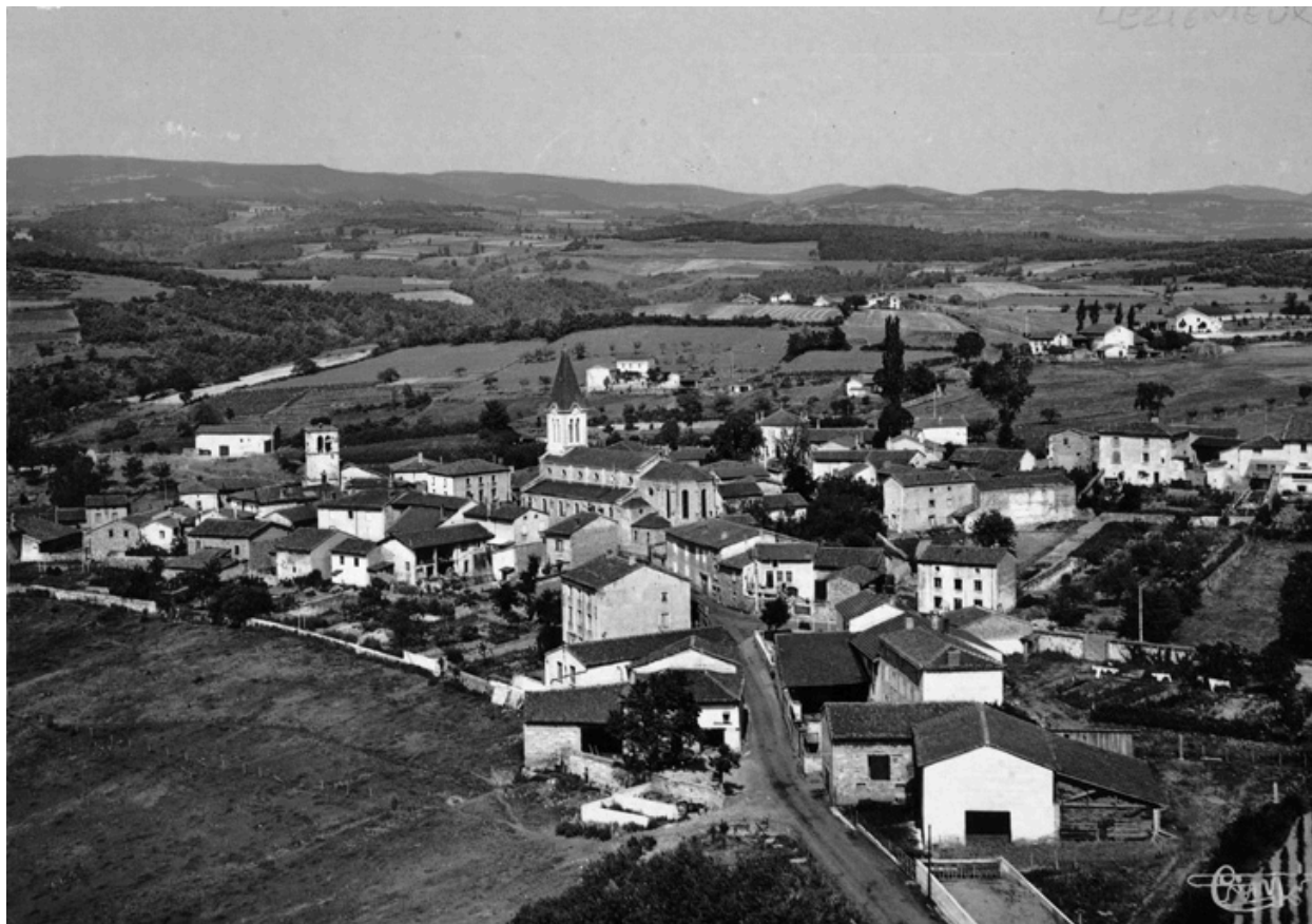
CIM / LEZIGNEUX (42 . Loire). AC 173-31 A - Vue générale aérienne. [Vue générale aérienne du bourg, depuis l'est].
