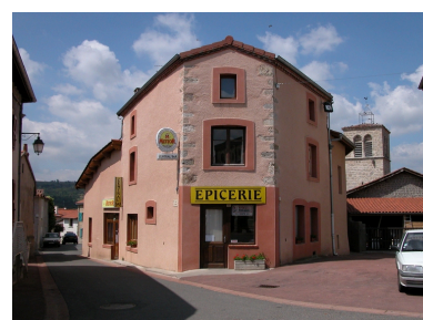
Vue d'ensemble de la parcelle 1984 E 4. Phot. Thierry Monnet IVR82_20124200309NUCA
