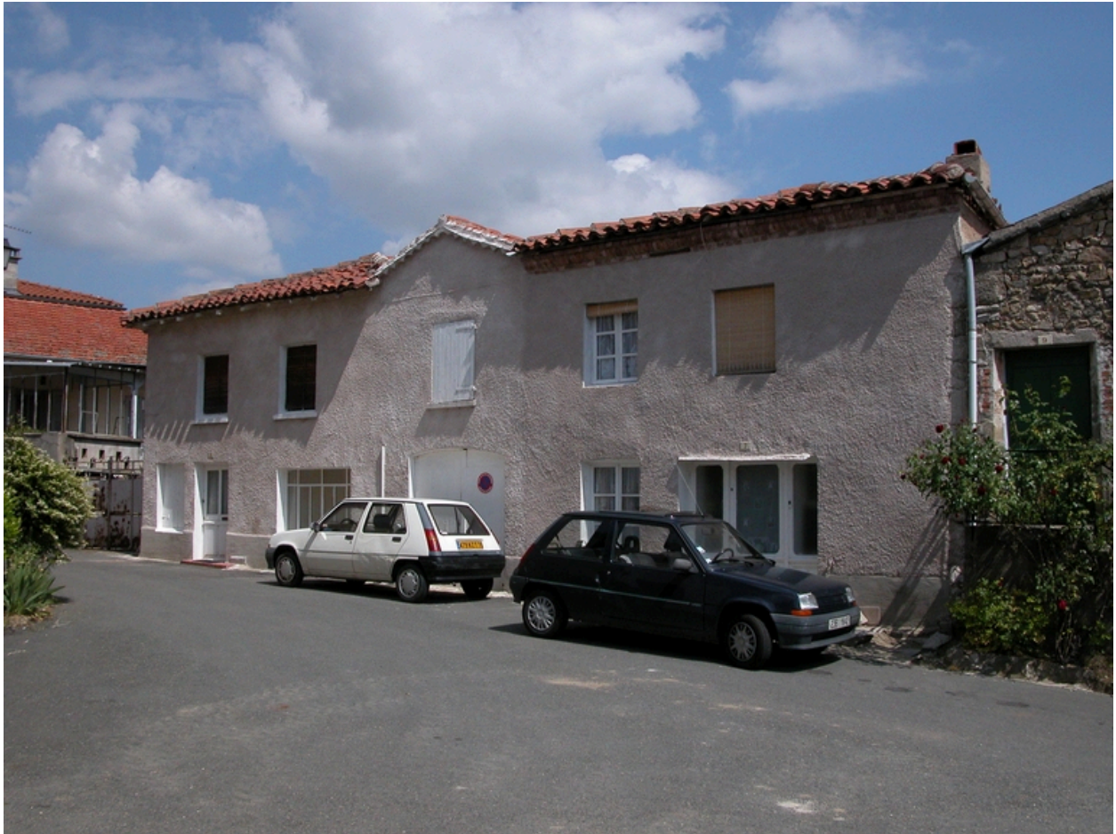
Vue d'ensemble la parcelle 1984 E 123 : maison avec vestiges du 16e siècle.
