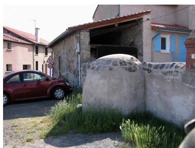
Parcelle 1984 E 53, puits. Phot. Thierry Monnet IVR82_20124200264NUCA
