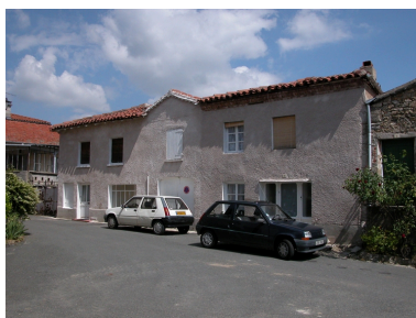
Vue d'ensemble la parcelle 1984 E 123 : maison avec vestiges du 16e siècle. Phot. Thierry Monnet IVR82_20124200287NUCA
