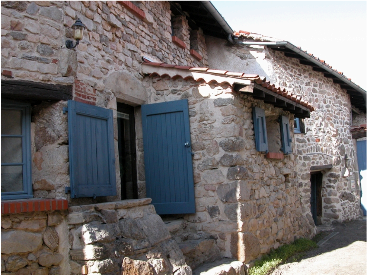
Vue de la parcelle 1984 E 80, côté cour.
