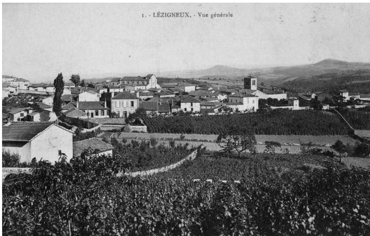
I. - LÉZIGNEUX . - Vue générale. [Vue générale du bourg, depuis l'ouest].
