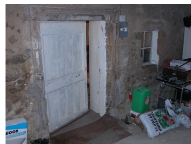
Vue intérieure de la parcelle 1984 E 123, maison de gauche : encadrement de porte du 16e siècle. Phot. Thierry Monnet IVR82_20124200286NUCA
