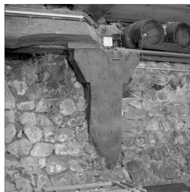
Détail d'un des poteaux de la cave. Phot. Jean-Marie Refflé IVR82_20014200187X
