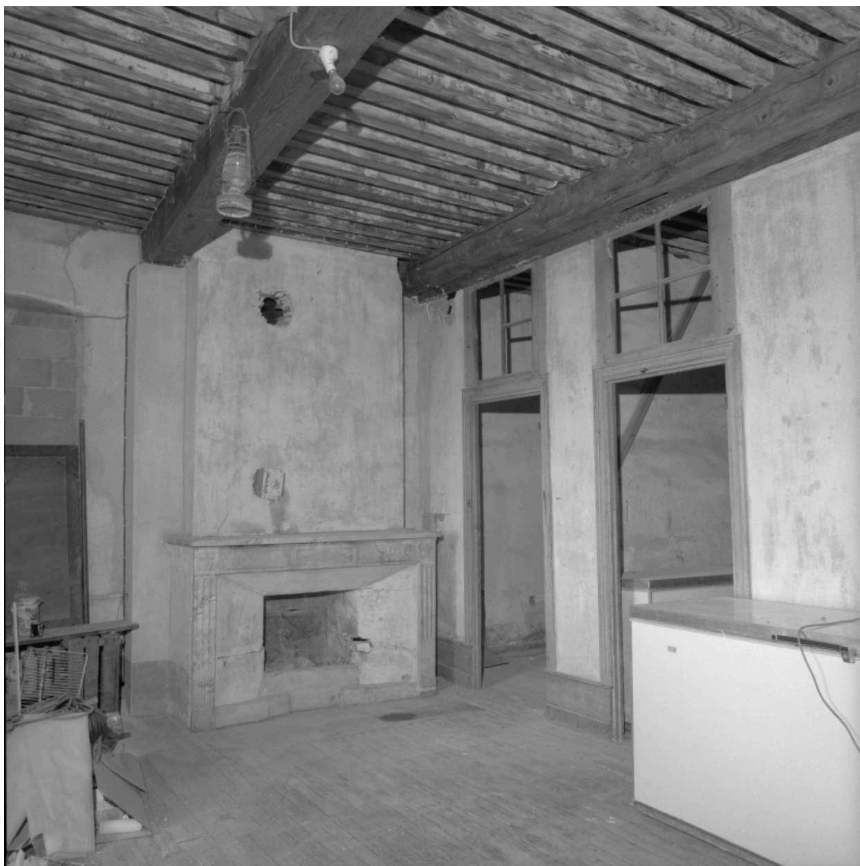
Vue d'ensemble intérieure de la chambre 3, depuis le nord.
