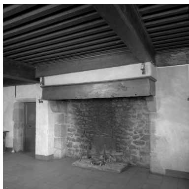
Vue d'ensemble de la cheminée de la salle à manger. Phot. Jean-Marie Refflé IVR82_20014200185X
