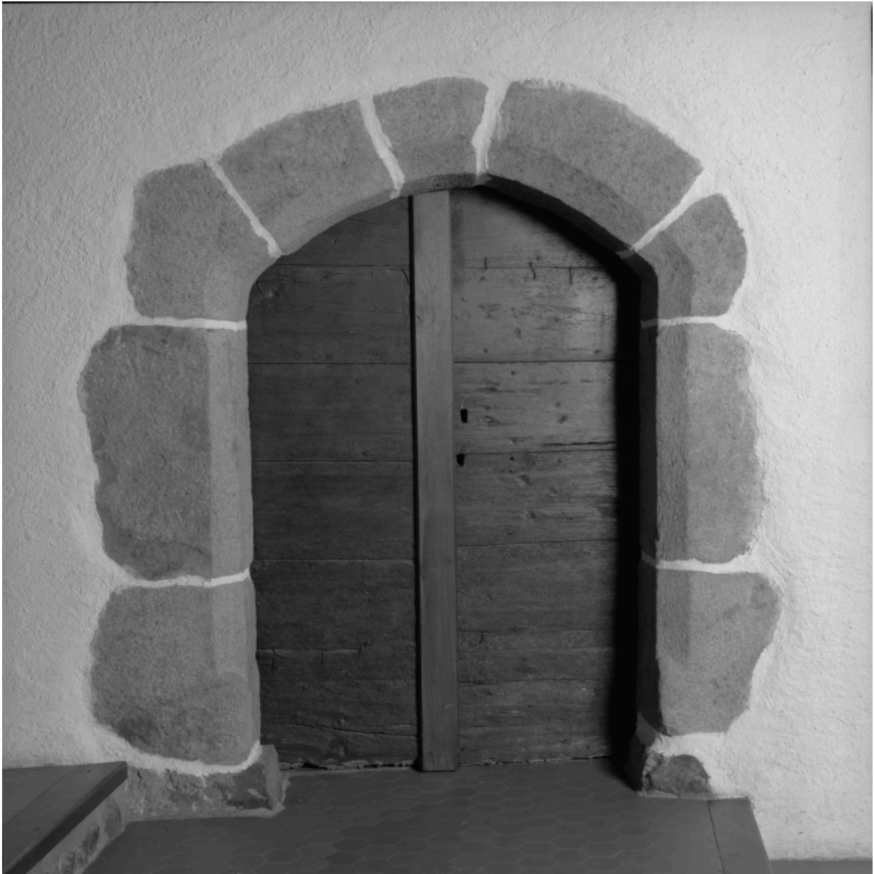
Porte d'accès à la cave (vraisemblablement remontée).
