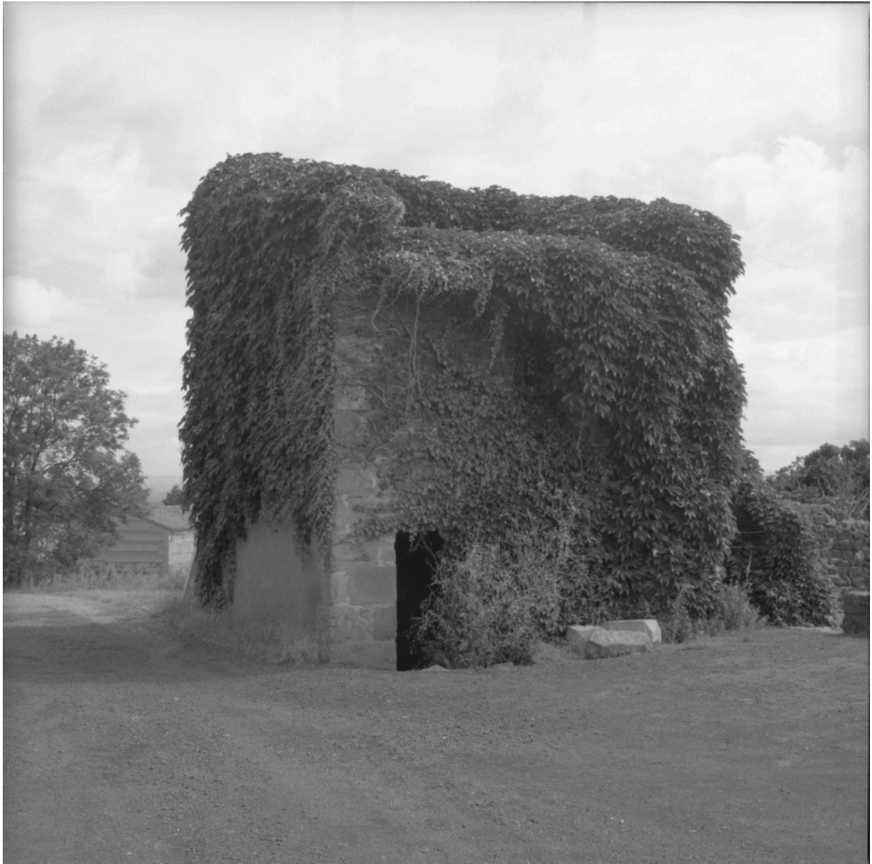
Vue d'ensemble du colombier situé dans un des angles de la cour de l'auberge.
