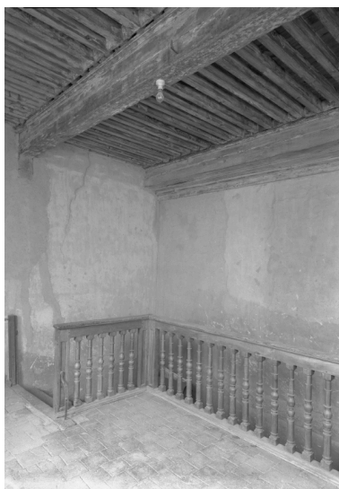
Palier du rez-de-chaussée surélevé. Phot. Jean-Marie Refflé IVR82_20014200189P
