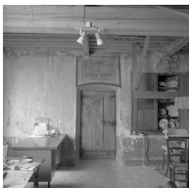
Vue d'ensemble intérieure de la chambre 2, depuis le nord. Phot. Jean-Marie Refflé IVR82_20014200193X
