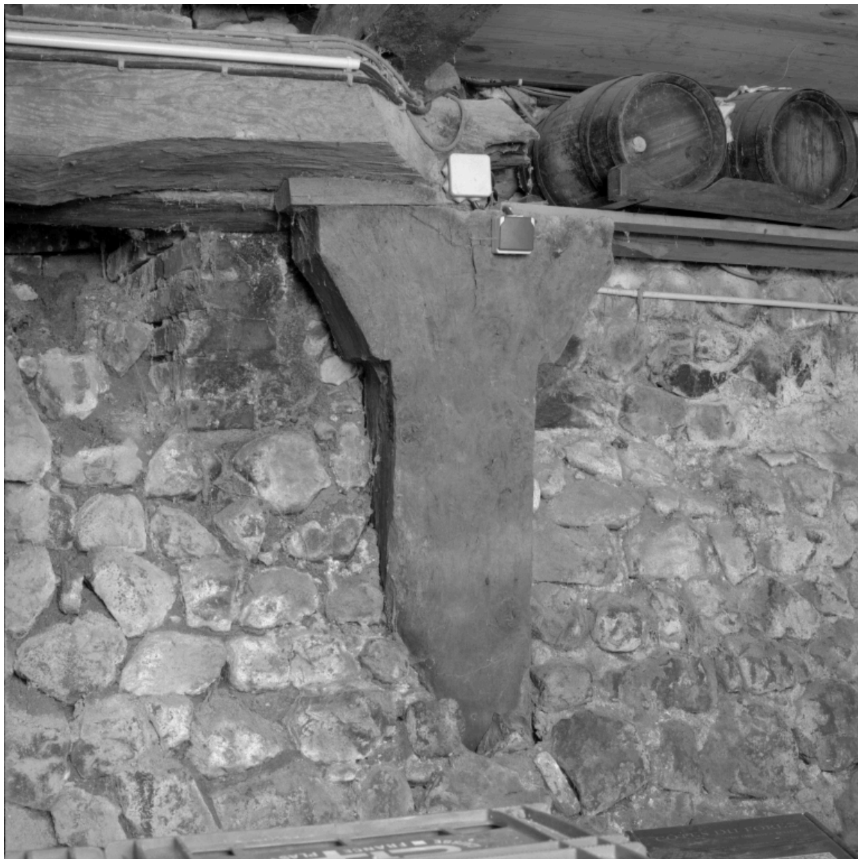
Détail d'un des poteaux de la cave.
