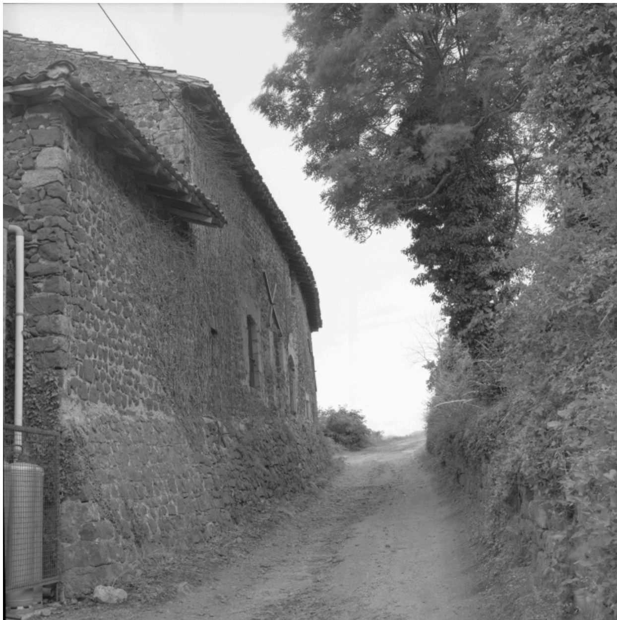
Vue d'ensemble de l'élévation postérieure du logis.
