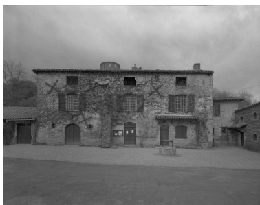
Vue d'ensemble depuis l'est (sans feuilles). Phot. Eric Dessert IVR82_20024201533V
