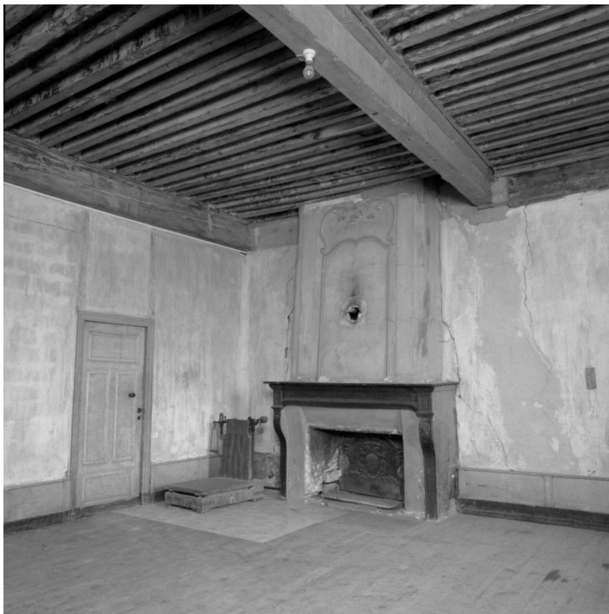
Vue d'ensemble intérieure de la chambre 1, depuis le sud.
