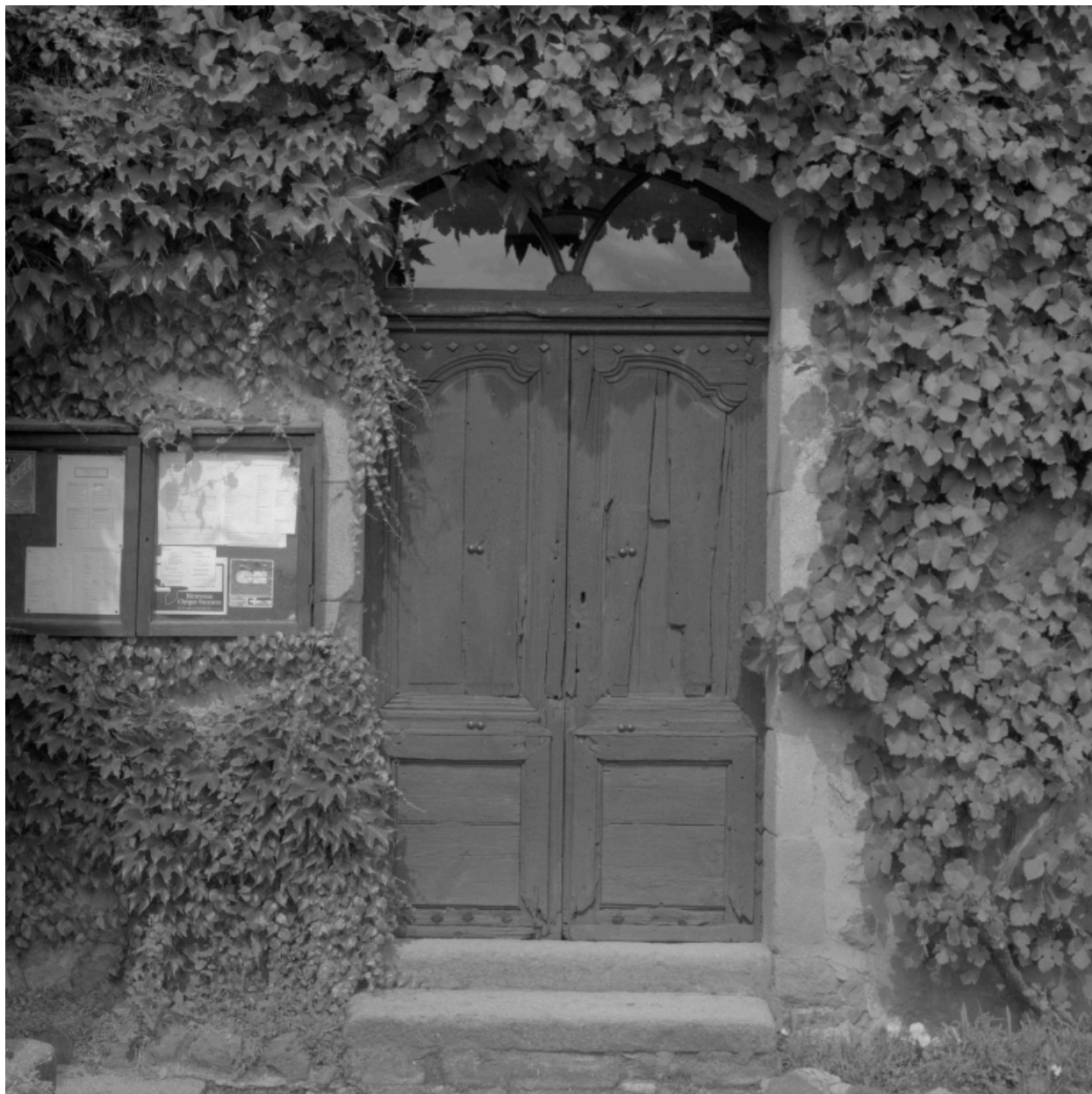
Détail de la porte d'entrée.
