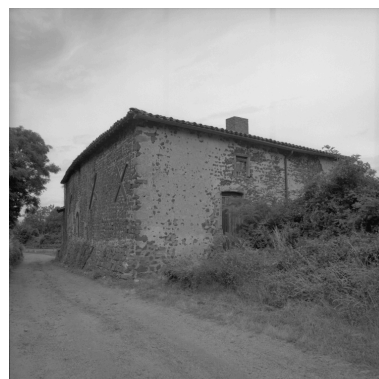
Vue d'ensemble depuis le sud-ouest. Phot. Jean-Marie Refflé IVR82_20014200184X
