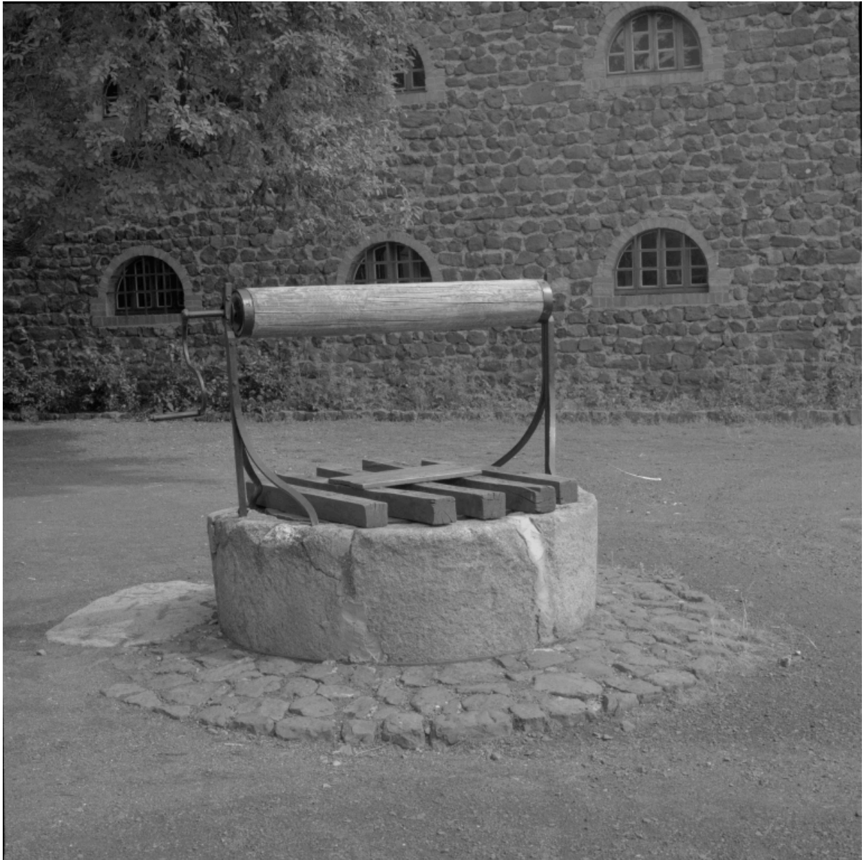
Vue d'ensemble du puits, à margelle en pierre, situé dans la cour intérieure de l'auberge.
