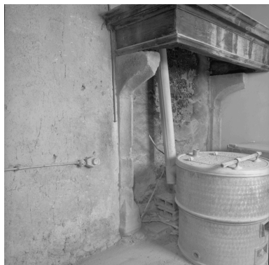
Cheminée de la cuisine. Phot. Jean-Marie Refflé IVR82_20014200197X
