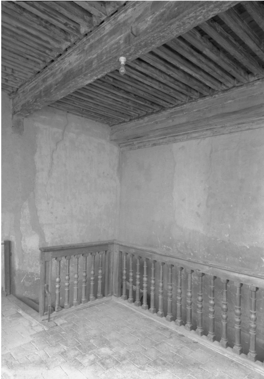
Palier du rez-de-chaussée surélevé.
