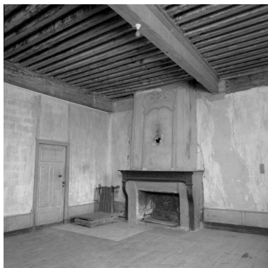
Vue d'ensemble intérieure de la chambre 1, depuis le sud. Phot. Jean-Marie Refflé IVR82_20014200190X
