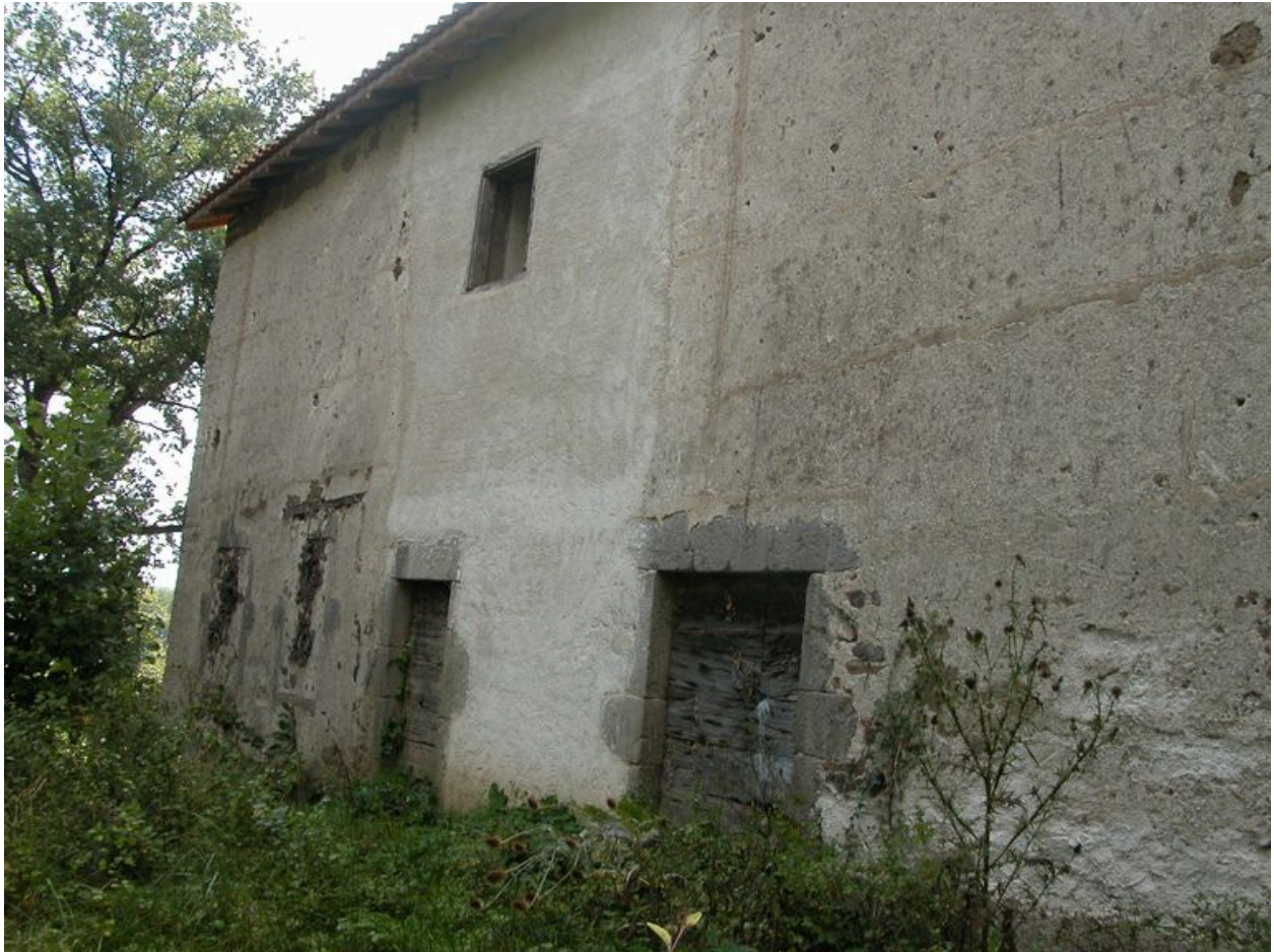
Vue de la grange-étable, depuis le nord-ouest.
