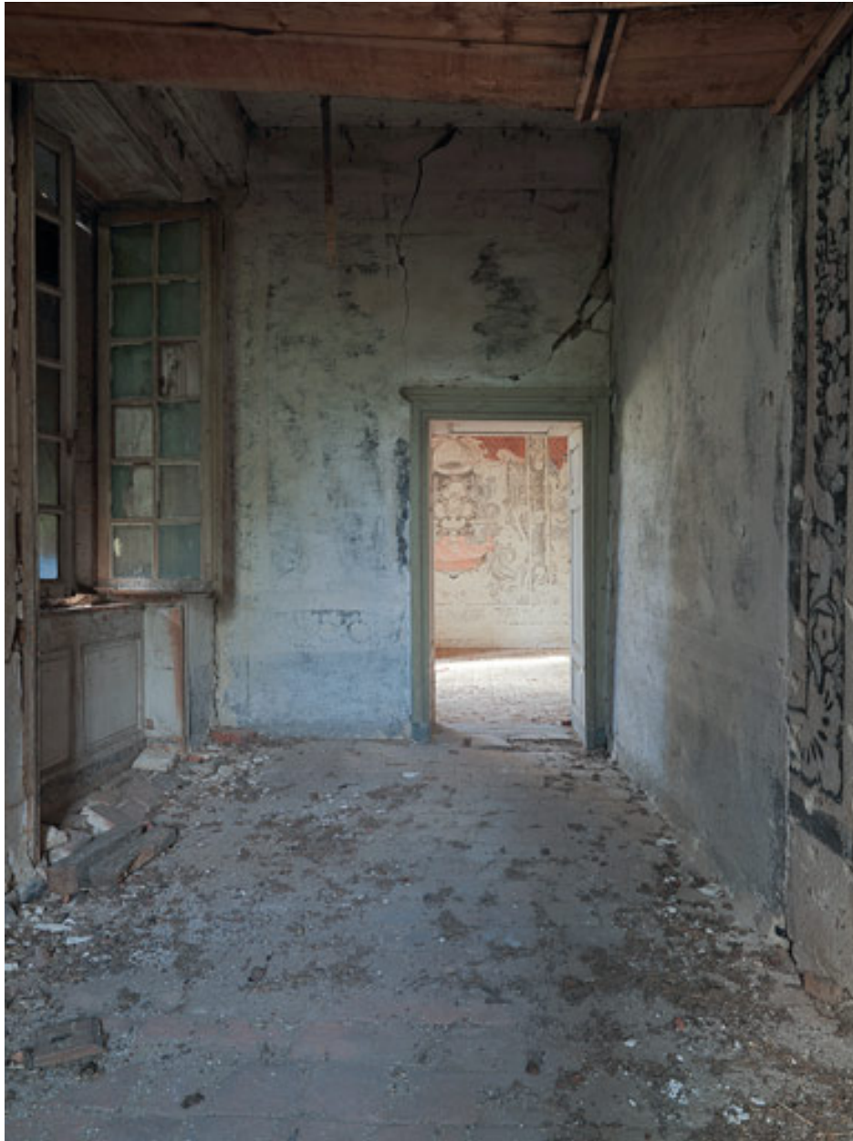
Vue intérieure du 1er étage : pièce A.
