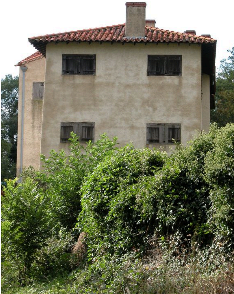
Vue de l'élévation nord, depuis le nord-est.
