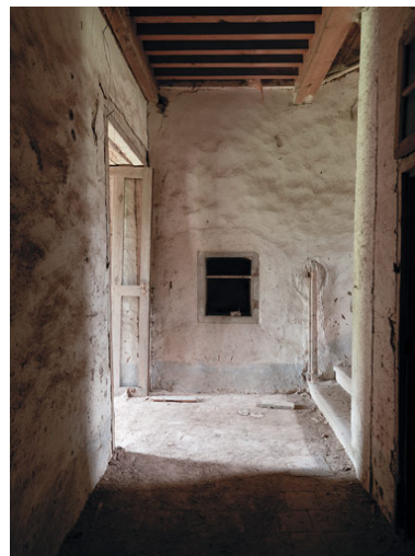
Vue intérieure du vestibule du rez-de-chaussée, depuis le nord. Phot. M. Couderette IVR82_20094200792NUCA
