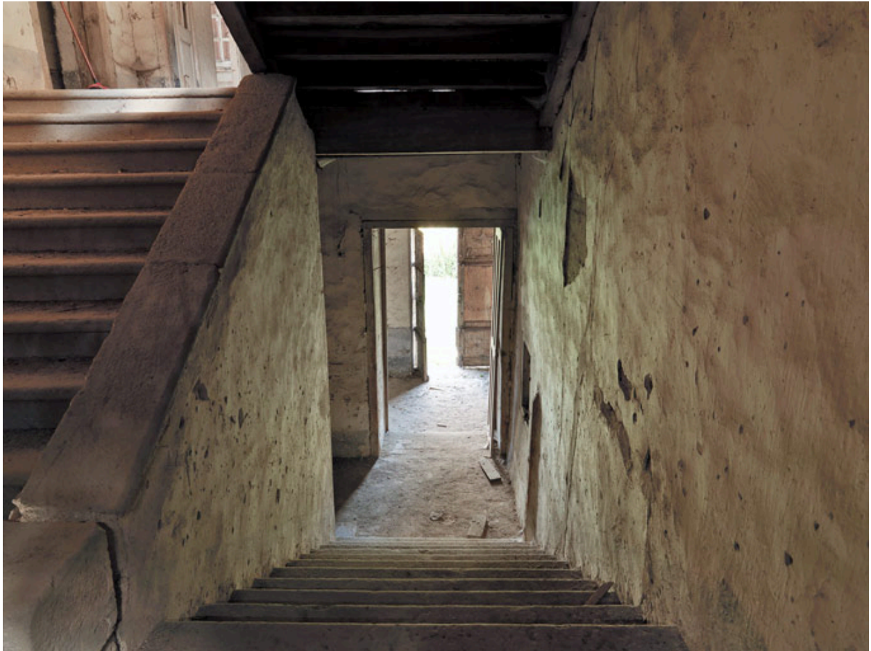
Vue intérieure de l'escalier, depuis le premier pallier.
