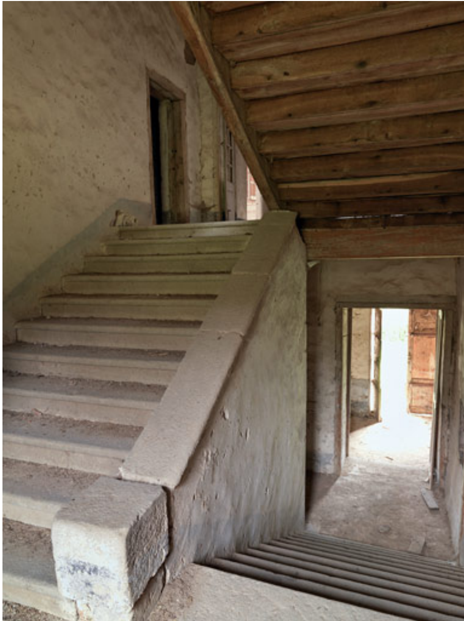
Vue intérieure de l'escalier, depuis le premier pallier.
