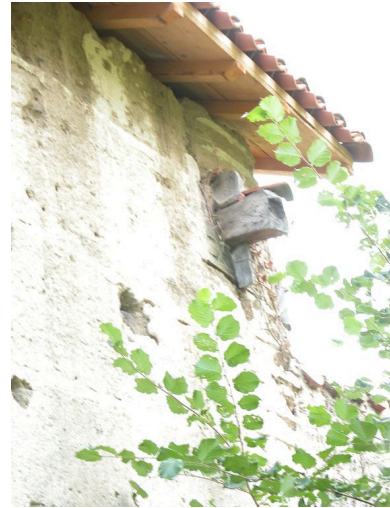
Détail de la grange- étable : clef de serrage. Phot. Caroline Guibaud IVR82_20124203134NUCA
