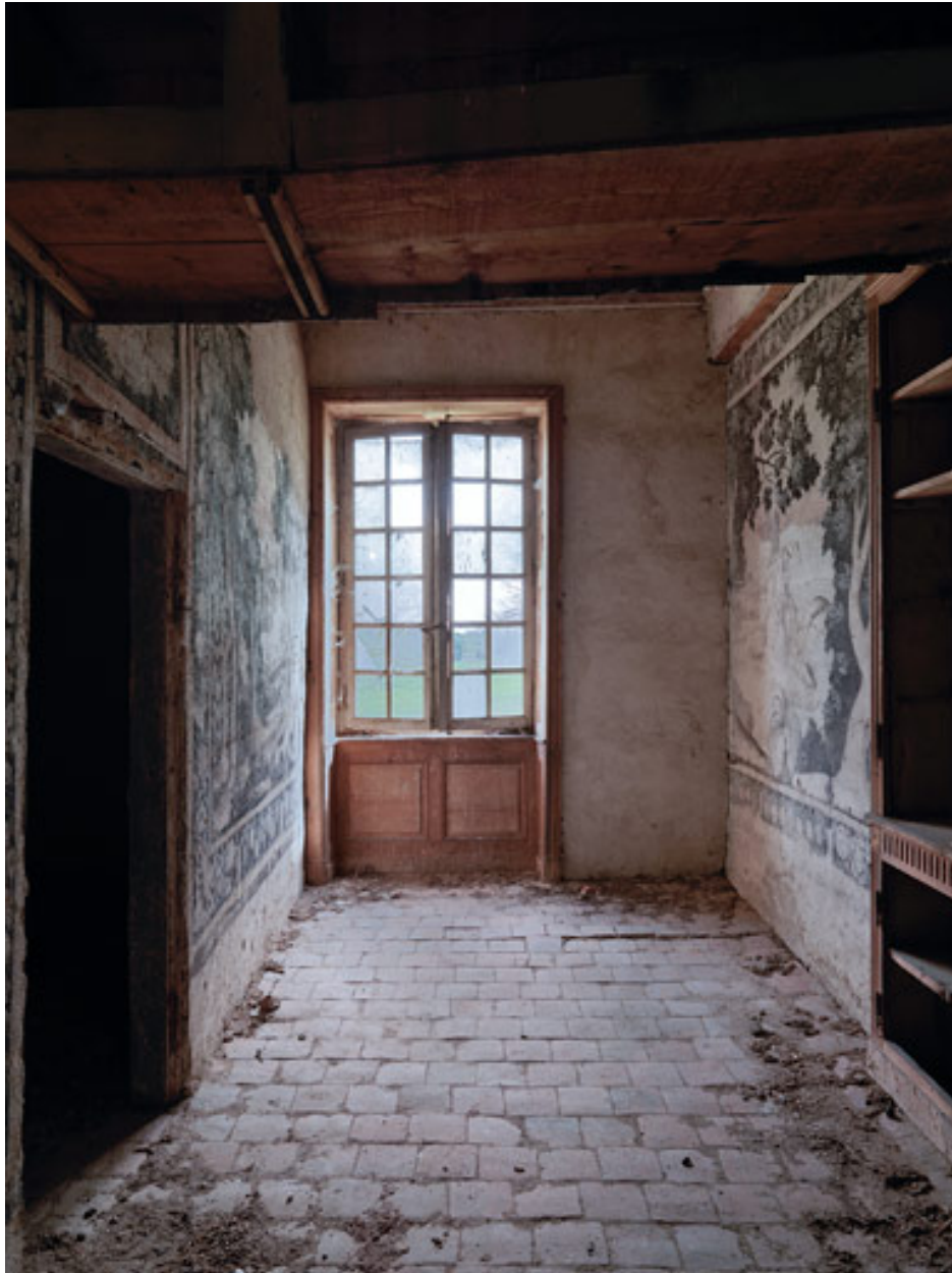
Vue intérieure du 1er étage : pièce B.
