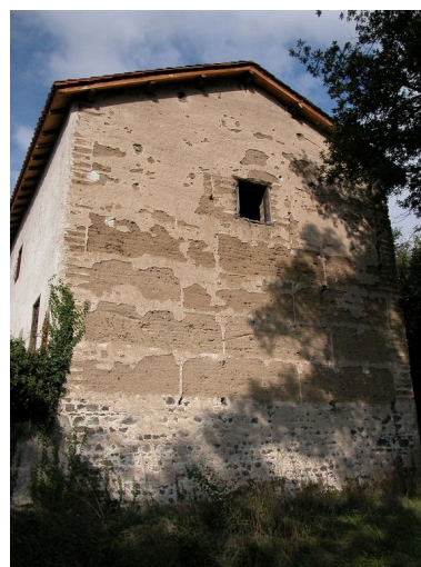
Pignon est de la grange-étable. Phot. Caroline Guibaud IVR82_20124203131NUCA
