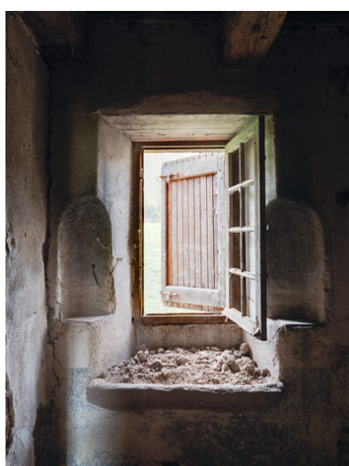
Vue intérieure du rez-de- chaussée : évier. Phot. M. Couderette
