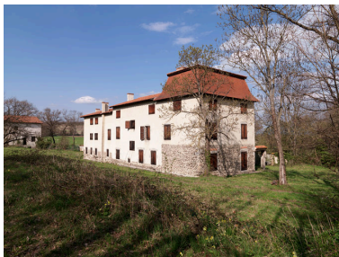
Vue générale depuis le sud-ouest. Phot. M. Couderette IVR82_20094200768NUCA
