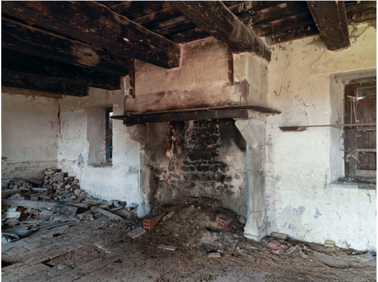
Vue intérieure du rez-de-chaussée : cuisine, cheminée.
