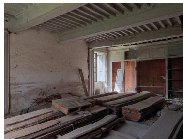
Vue intérieure du rez-de-chaussée : salon. Phot. M. Couderette IVR82_20094200941NUCAQ
