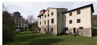
Vue d'ensemble depuis le nord-est. Phot. M. Couderette IVR82_20094200930NUCAQ
