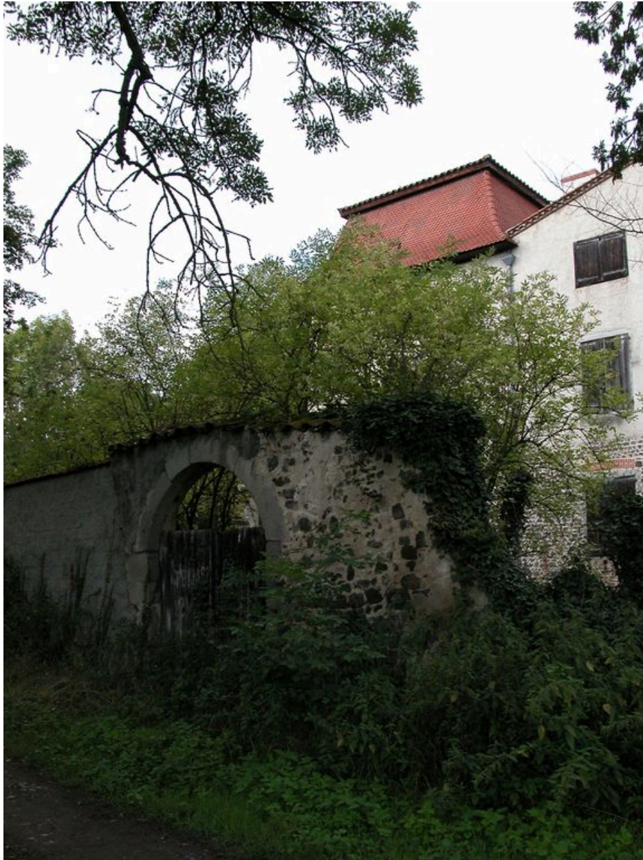
Mur de clôture et portail d'entrée, depuis l'est.
