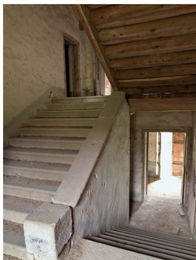
Vue intérieure de l'escalier, depuis le premier pallier. Phot. M. Couderette IVR82_20094200786NUCA
