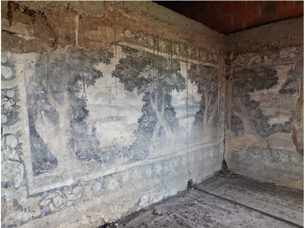
Vue intérieure du 2e étage : peintures murales.
