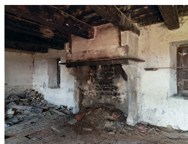
Vue intérieure du rez-de- chaussée : cuisine, cheminée. Phot. M. Couderette IVR82_20094200781NUCA
