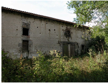
Vue de la grange- étable, depuis le nord. Phot. Caroline Guibaud IVR82_20124203132NUCA
