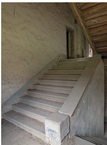
Vue intérieure de l'escalier, depuis le premier pallier. Phot. M. Couderette IVR82_20094200787NUCA
