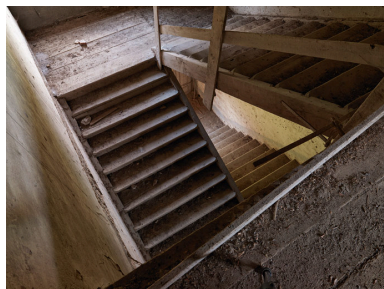
Vue intérieure de l'escalier, depuis le pallier du 2e étage. Phot. M. Couderette IVR82_20094200810NUCA
