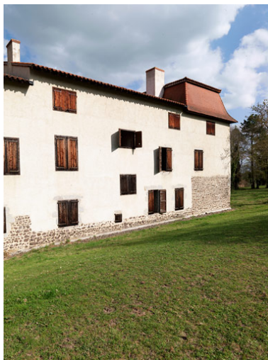
Vue depuis le nord-ouest. Phot. M. Couderette IVR82_20094200769NUCA
