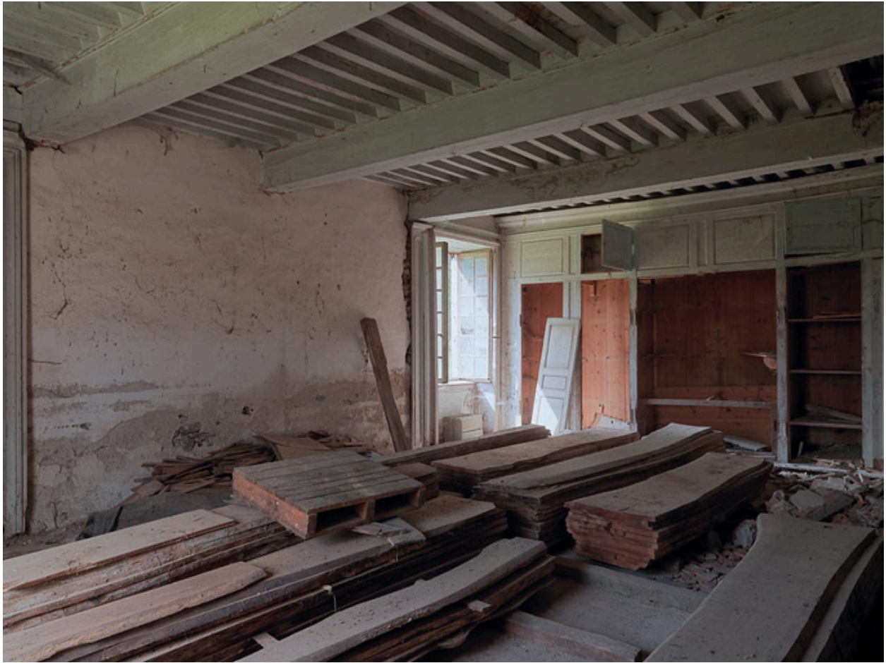
Vue intérieure du rez-de-chaussée : salon.
