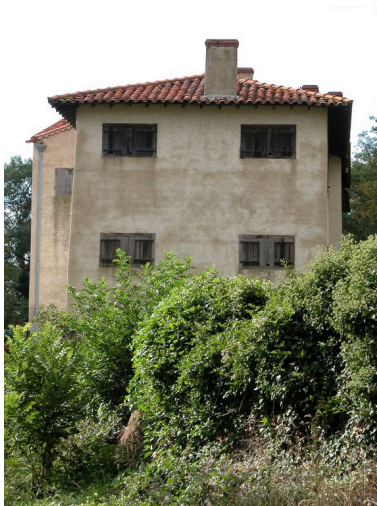
Vue de l'élévation nord, depuis le nord-est. Phot. Thierry Monnet IVR82_20124203135NUCA
