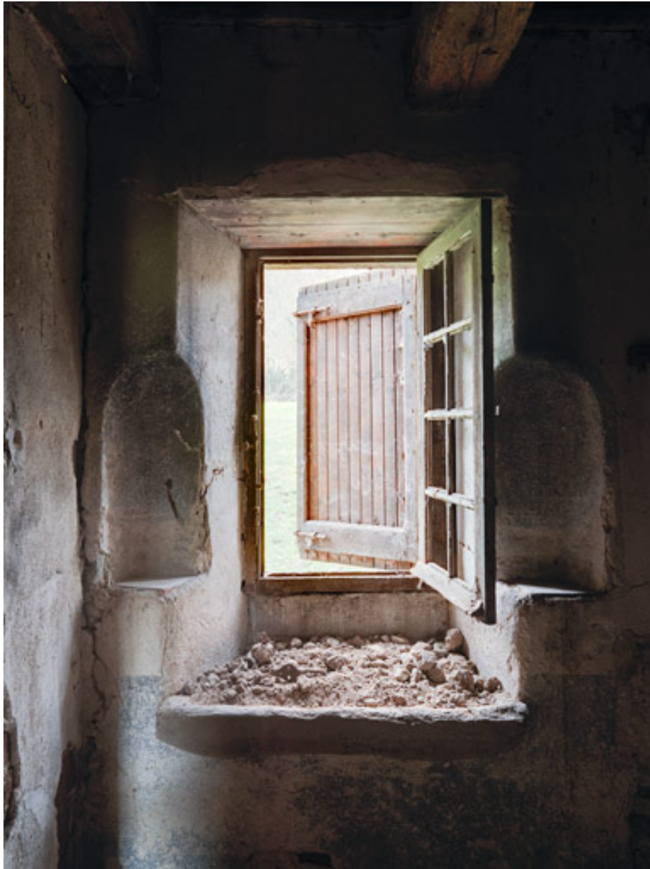
Vue intérieure du rez-de-chaussée : évier.
