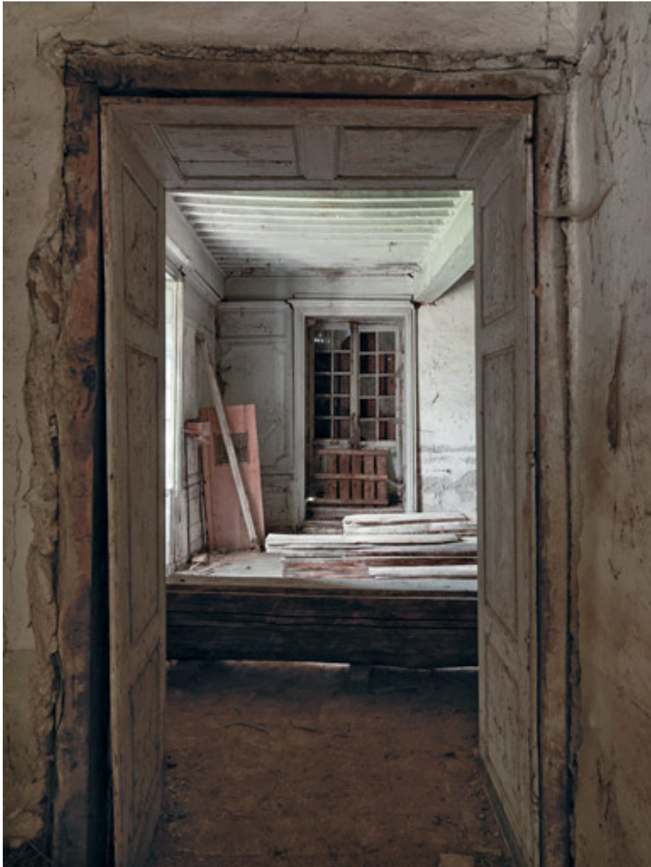
Vue intérieure du rez-de-chaussée : entrée du salon.
