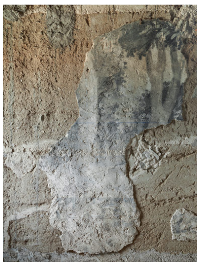
Vue intérieure du 2e étage : détail de peintures murales. Phot. M. Couderette IVR82_20094200809NUCA
