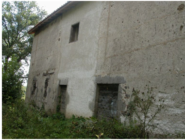
Vue de la grange-étable, depuis le nord-ouest. Phot. Caroline Guibaud IVR82_20124203133NUCA
