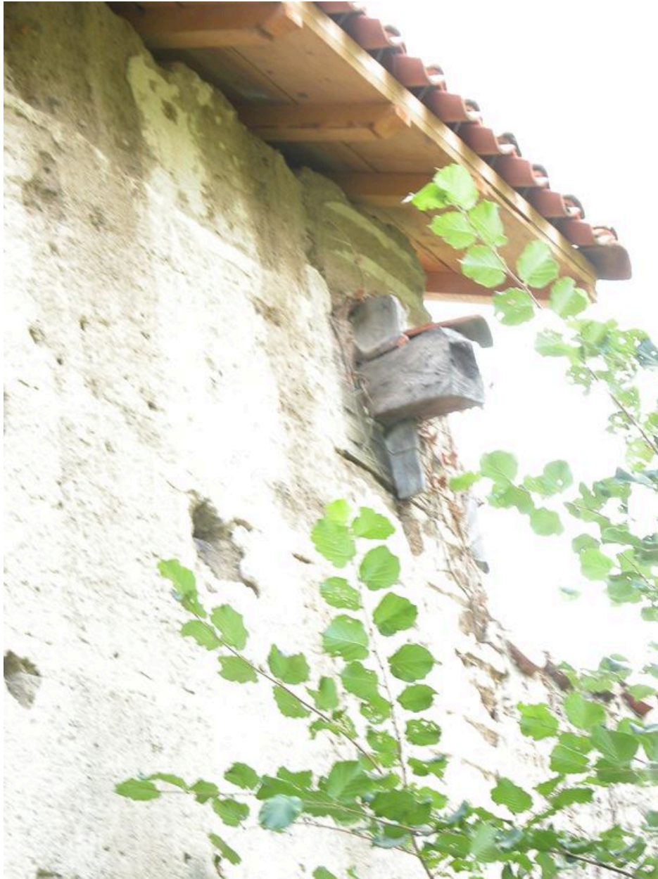
Détail de la grange-étable : clef de serrage.
