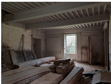
Vue intérieure du rez-de-chaussée : salon. Phot. M. Couderette IVR82_20094200942NUCAQ
