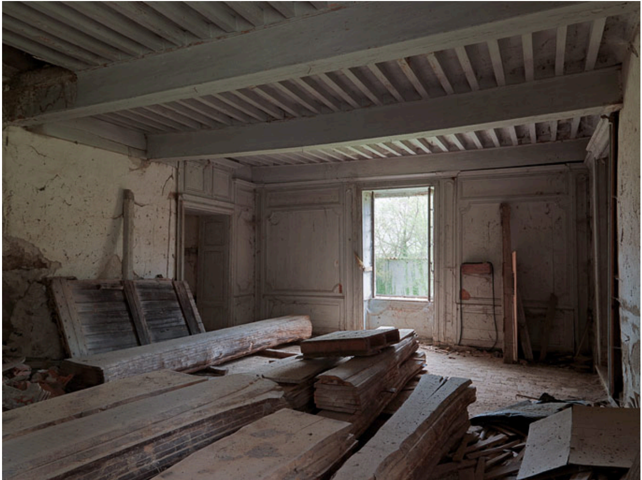
Vue intérieure du rez-de-chaussée : salon.
