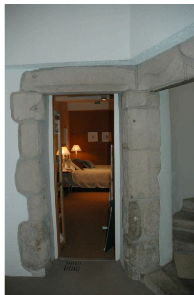
Encadrement de porte avec linteau à cavet. Phot. Simone Hartmann-Nussbaum IVR82_20114201321NUCA
