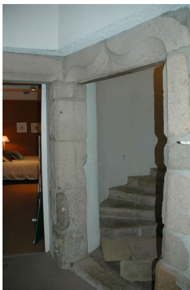
Encadrement de porte avec linteau en accolade. Phot. Simone Hartmann-Nussbaum IVR82_20114201320NUCA
