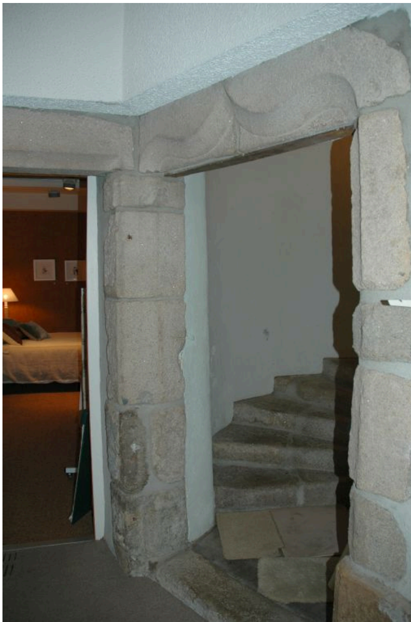
Encadrement de porte avec linteau en accolade.
