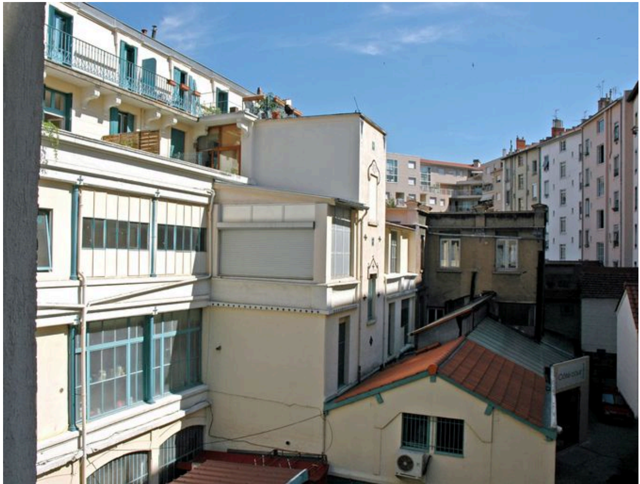
Vue d'ensemble de la cage d'escalier centrale portant le décor de céramique
