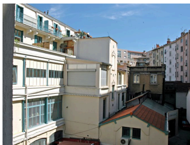
Vue d'ensemble de la cage d'escalier centrale portant le décor de céramique Phot. Maryannick Chalabi IVR82_20076900224NUCA
