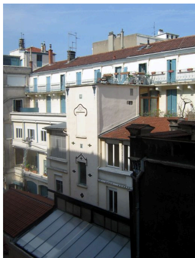
Vue d'ensemble de la cage d'escalier centrale portant le décor de céramique, depuis le nord Phot. Catherine Guégan IVR82_20116904144NUCA
