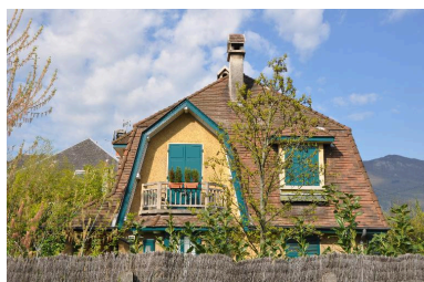
Façade orientale Phot. Denys Harreau IVR82_20137300070NUCA
