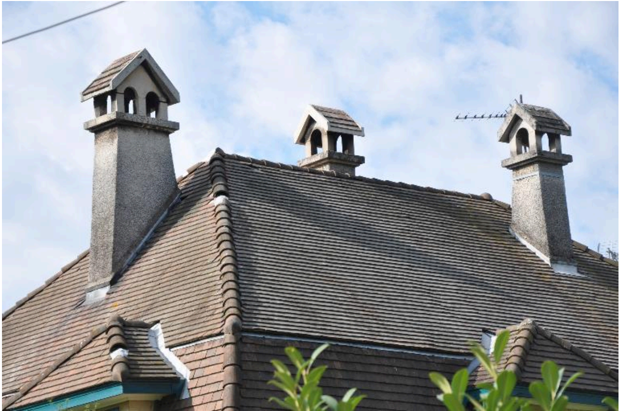
La toiture et les cheminées
