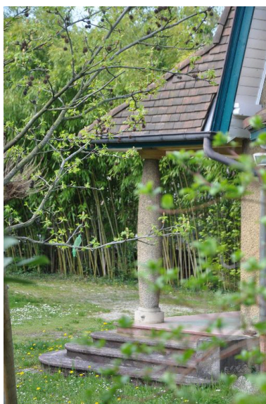
Emmarchement et colonne renflée Phot. Denys Harreau IVR82_20137300073NUCA
