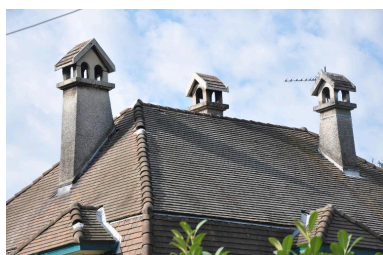
La toiture et les cheminées Phot. Denys Harreau IVR82_20137300071NUCA
