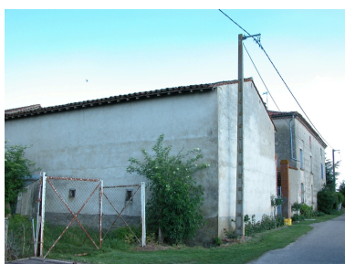
Vue d'ensemble depuis le chemin, du sud-ouest. Phot. Thierry Monnet IVR82_20134201685NUCA
