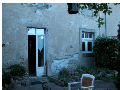
Détail de la façade sur cour du logis ; à droite, ancienne porte d'entrée transformée en fenêtre. Phot. Thierry Monnet IVR82_20134201683NUCA
