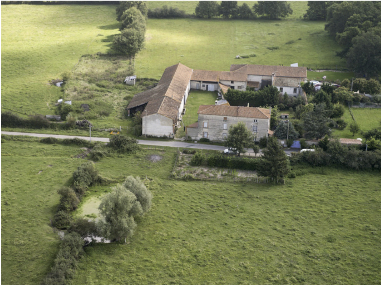
Vue aérienne, depuis l'ouest.
