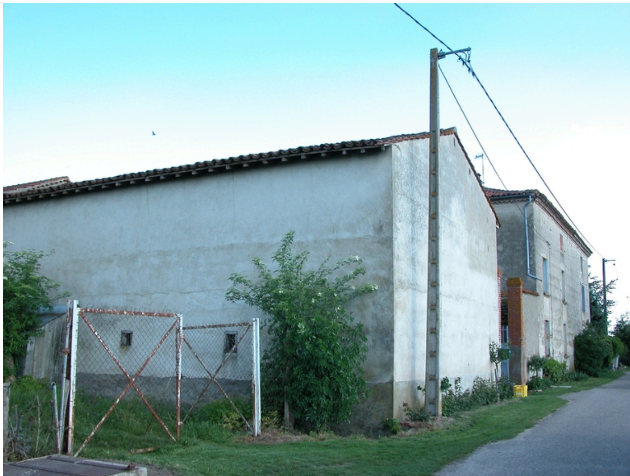
Vue d'ensemble depuis le chemin, du sud-ouest.
