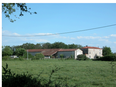
Vue générale depuis le nord-ouest. Phot. Thierry Monnet IVR82_20134201681NUCA
