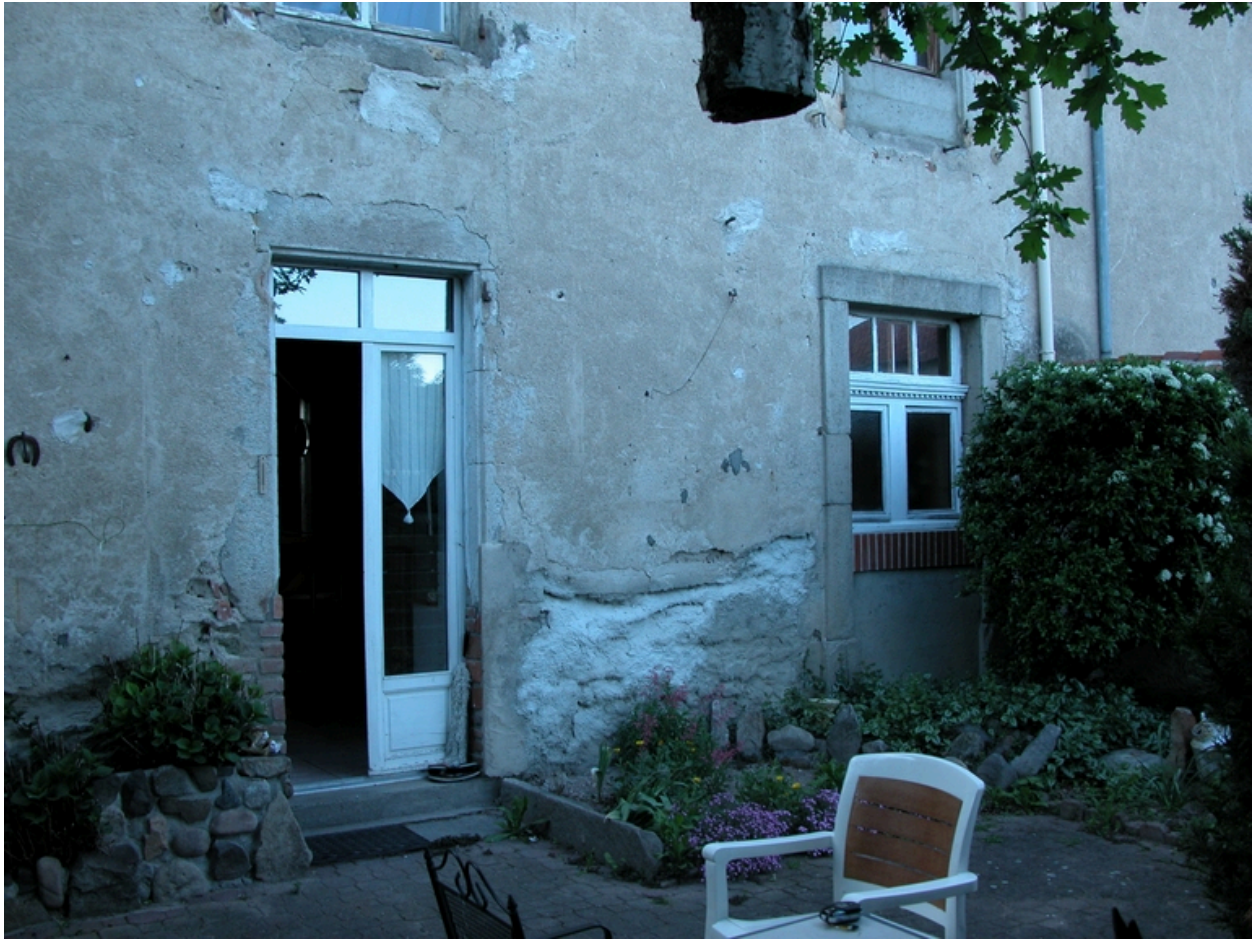
Détail de la façade sur cour du logis ; à droite, ancienne porte d'entrée transformée en fenêtre.
