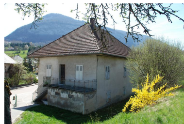
Vue d'ensemble du bâtiment en retour, parcelle 2049. Phot. Thierry Monnet IVR84_20197400191NUCA
