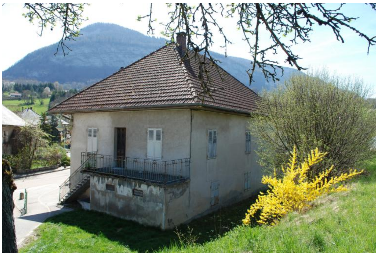
Vue d'ensemble du bâtiment en retour, parcelle 2049.
