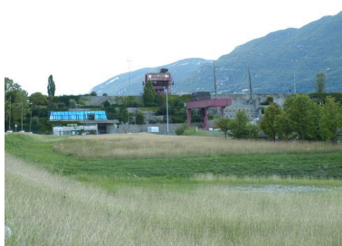
Vue générale, face amont Phot. B. Decrock IVR82_20100100157NUCA
