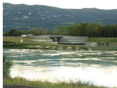
Vue générale, face aval Phot. B. Decrock IVR82_20100100158NUCA
