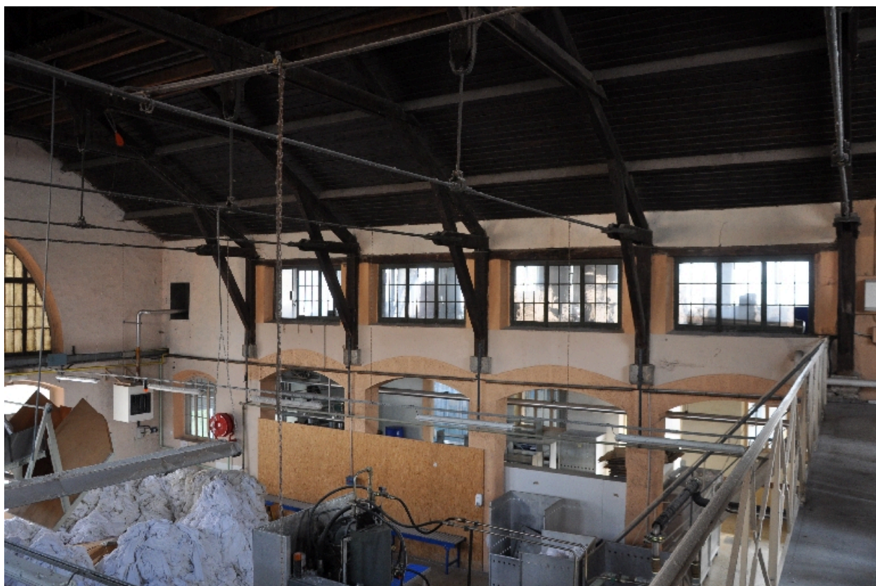
Vaisseau central, vue vers le sud
