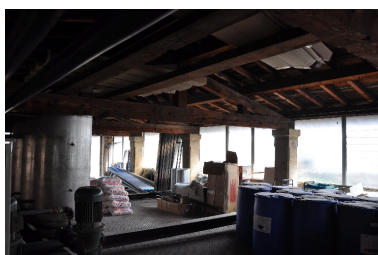
Demi-étage technique de l'aile sud Phot. François Fouger IVR82_20127300112NUCA
