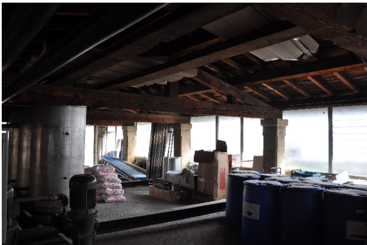
Demi-étage technique de l'aile sud
