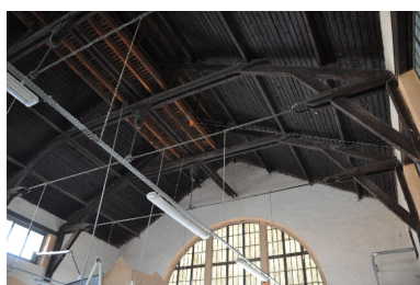
Vaisseau central : charpente en bois, vue sur le passage supérieur du lanterneau Phot. François Fouger IVR82_20127300108NUCA
