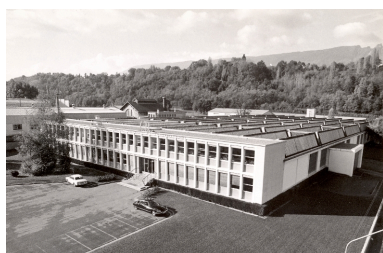
Bâtiments de la C.I.T. et blanchisserie en arrière plan, vers 1965-1970 Repro. François Fouger IVR82_20127300661NUCB
