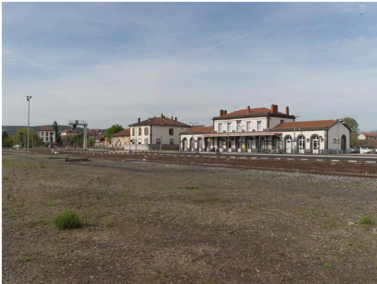
Vue générale de la gare d'Arvant côté voies ; à l'arrière-plan, la cité cheminote.
