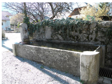
Vue d'ensemble du bassin. Phot. Jérôme Daviet IVR82_20107402645NUCA
