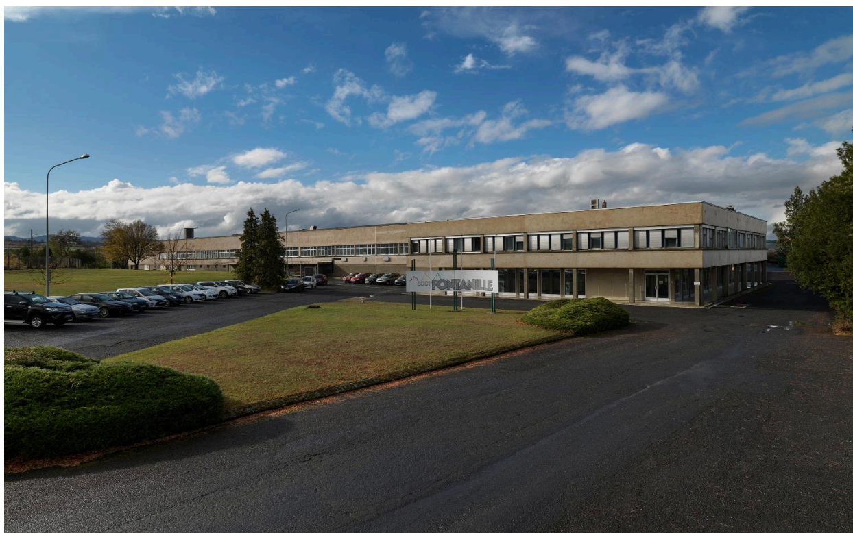
Vue d'ensemble de l'usine Fontanille site d'Espaly-Saint-Marcel
