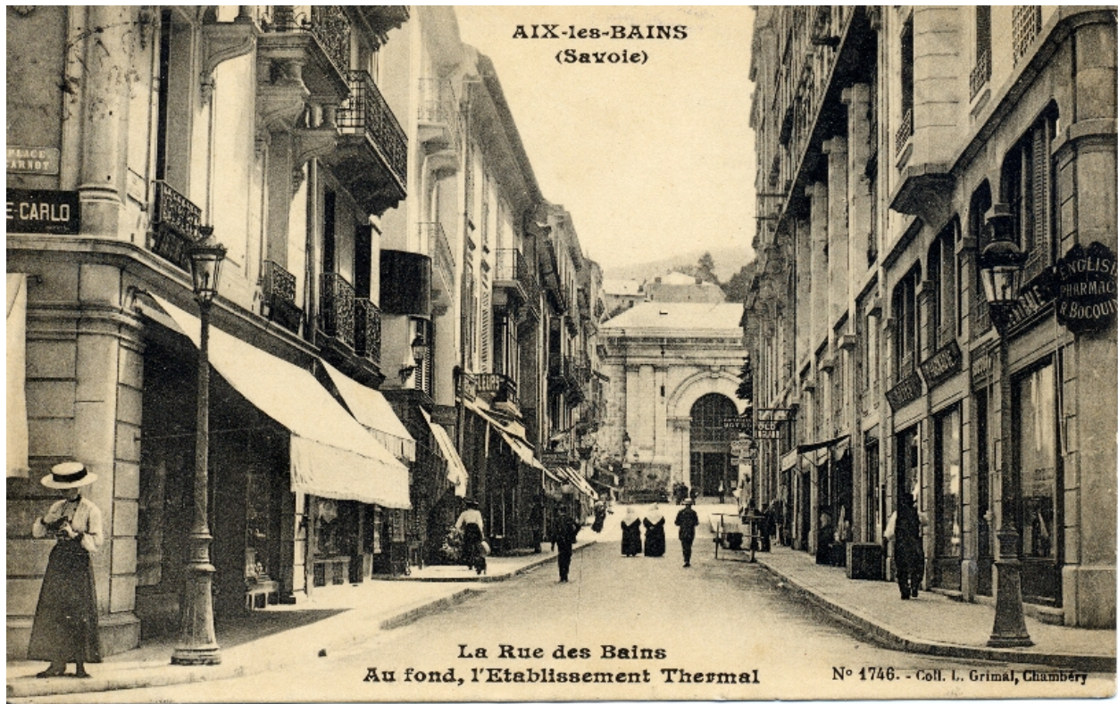
Façade rue des Bains
