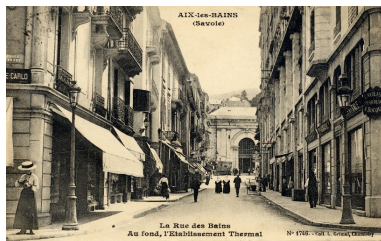
Façade rue des Bains Repro. François Fouger IVR82_20057300293NUCB
