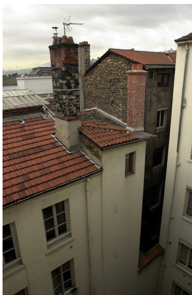
Elévation nord de la cage d'escalier depuis le 8 rue de l'Ancienne-Préfecture Phot. Véronique Belle IVR82_20076901204NUCA
