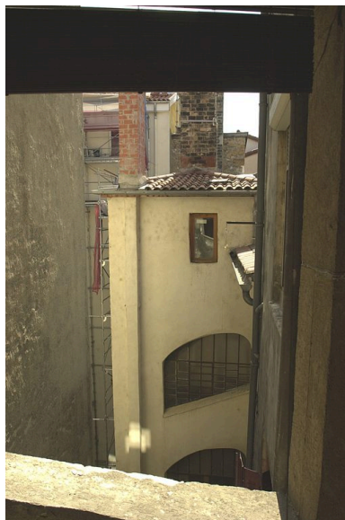
La cage d'escalier depuis celle du 11 rue du Port-du-Temple Phot. Véronique Belle IVR82_20086901286NUCA
