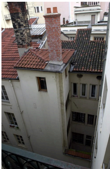
Elévations sur cour depuis l'escalier de l'immeuble sis 8 rue de l'Ancienne-Préfecture Phot. Véronique Belle IVR82_20076901203NUCA
