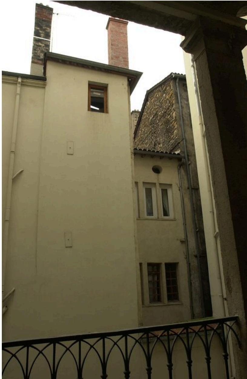
Elévations postérieures depuis l'escalier de l'immeuble sis 8 rue de l'Ancienne-Préfecture
