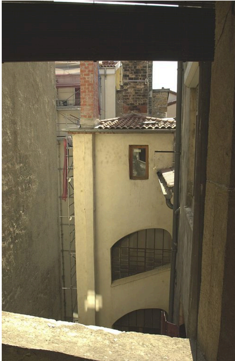
La cage d'escalier depuis celle du 11 rue du Port-du-Temple
