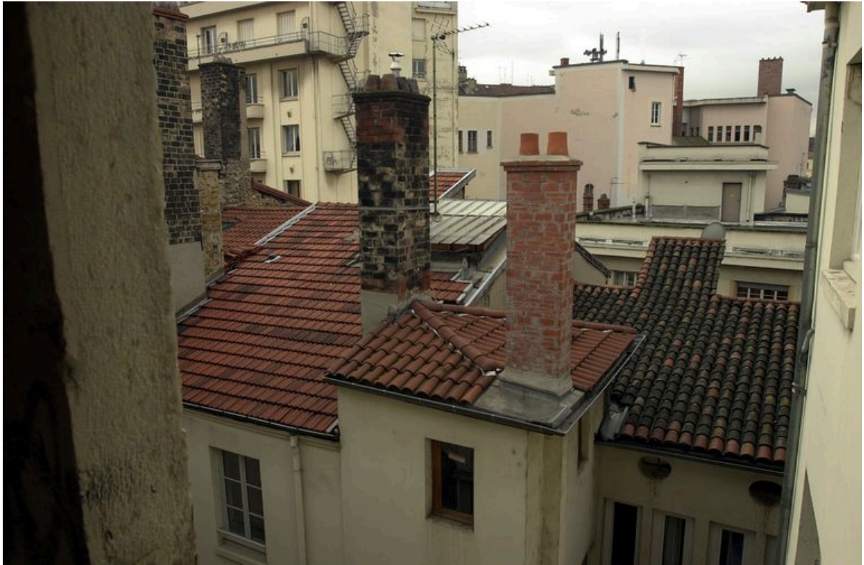
A droite, toiture depuis l'escalier de l'immeuble sis 8 rue de l'Ancienne-Préfecture
