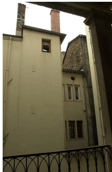
Elévations postérieures depuis l'escalier de l'immeuble sis 8 rue de l'Ancienne-Préfecture Phot. Véronique Belle IVR82_20076901202NUCA
