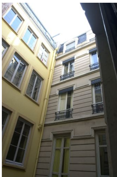
Façade en fond de cour Phot. Bernard Ducouret IVR82_20046900311NUCA
