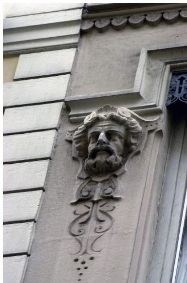
Façade sur rue, 2e étage, détail du premier mascarone en partant de la gauche Phot. A. Rémond IVR82_20046900308NUCA
