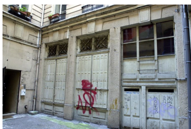
Cour, 1er niveau vu depuis le débouché de l'allée Phot. Phot. Inv. D. Chevallier IVR82_20046900312NUCA
