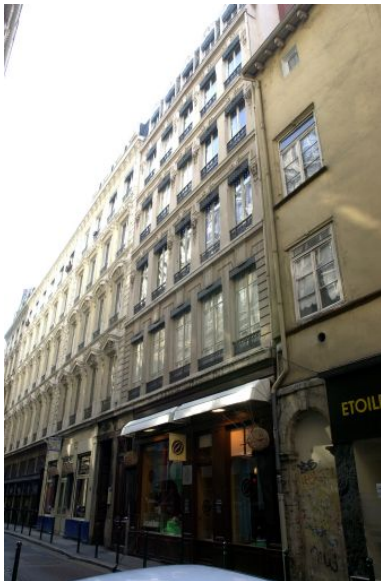
Vue générale de la façade sur rue Phot. Bernard Ducouret IVR82_20046900305NUCA
