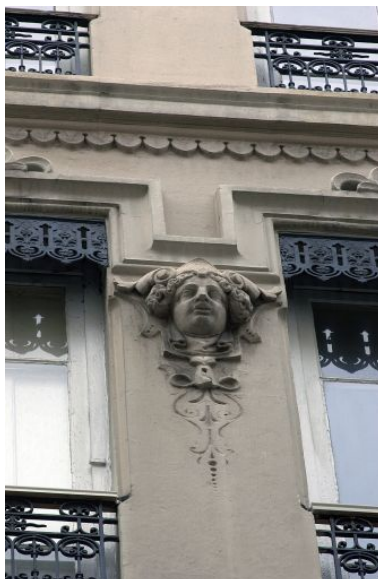
Façade sur rue, 3e étage, détail du 3e mascarone en partant de la gauche Phot. A. Rémond IVR82_20046900309NUCA
