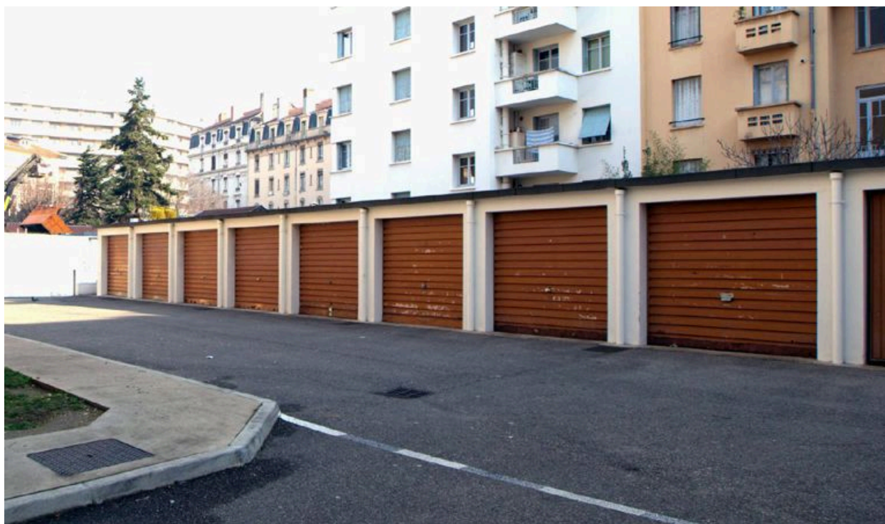
Vue du niveau supérieur, côté ouest
