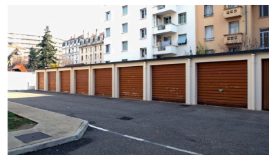
Vue du niveau supérieur, côté ouest Phot. Maryannick Chalabi IVR82_20106903546NUCA
