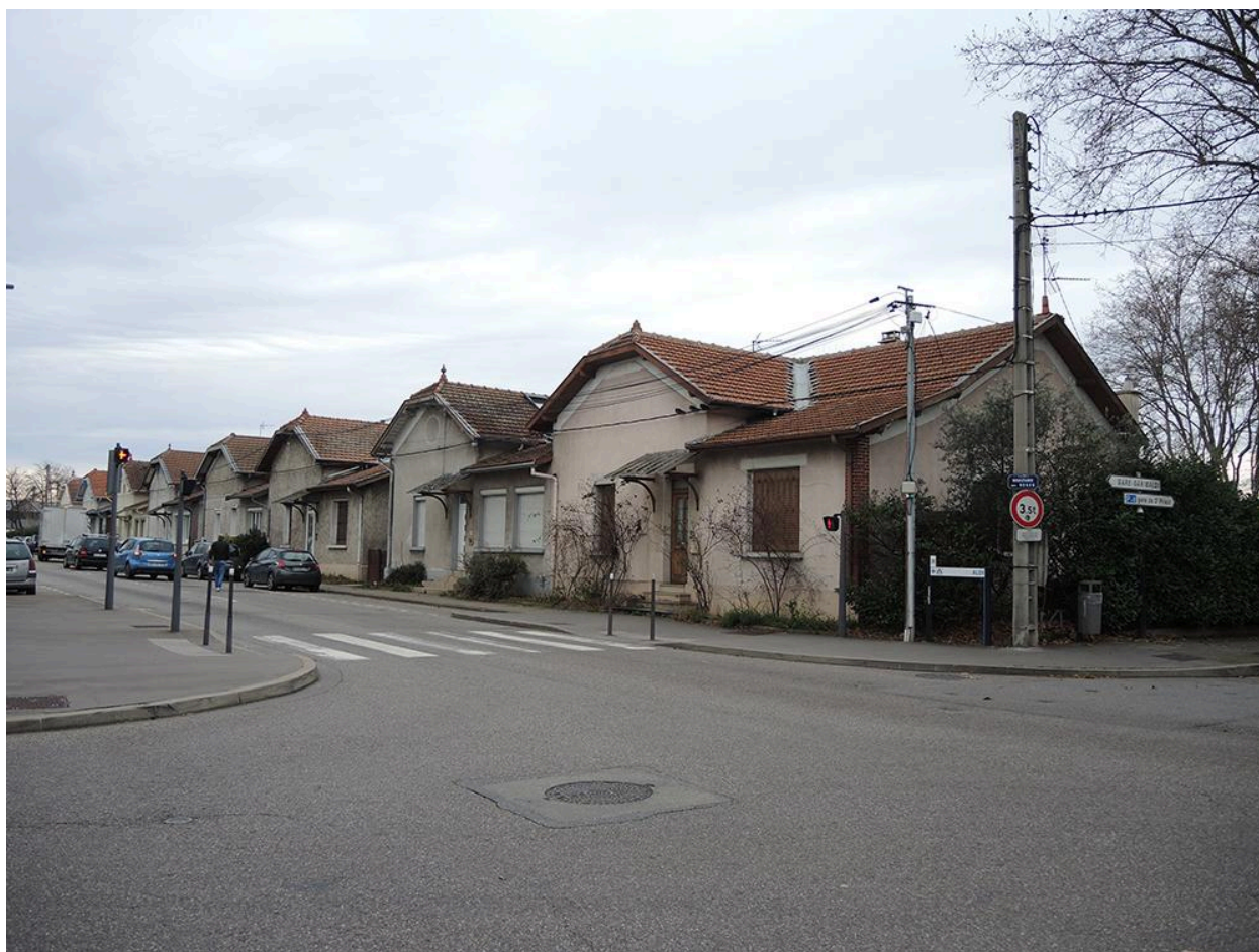
Cité ouvrière Maréchal vue d'ensemble des maisons
