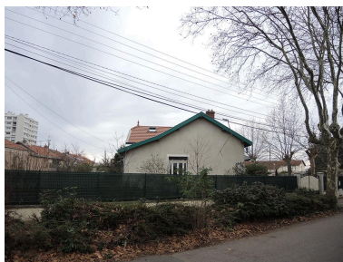
Cité ouvrière Maréchal, pignon maison et jardins Phot. Nadine Halitim-Dubois IVR84_20266900318NUCA
