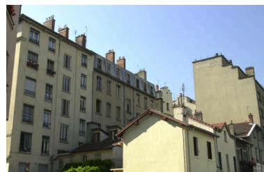
Elévation postérieure Phot. François Blanchetière IVR82_20016902318NUCA
