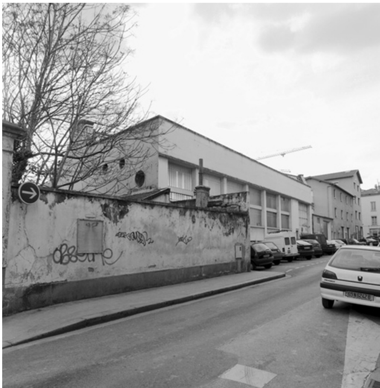
Vue d'ensemble est
