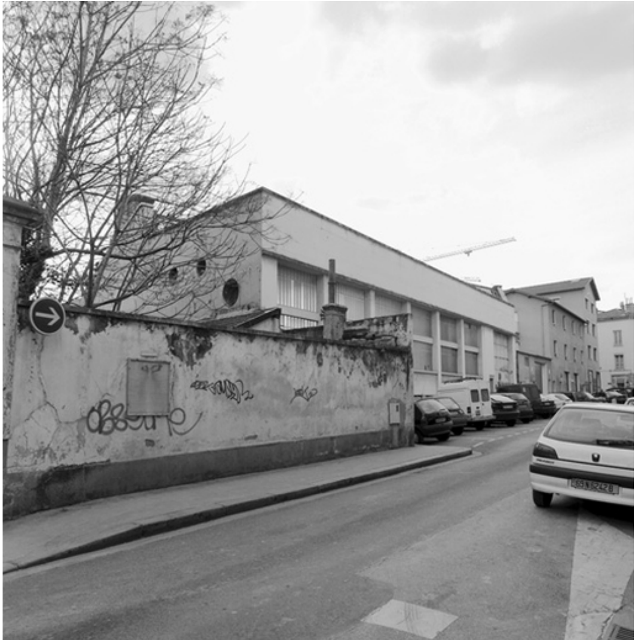
Vue d'ensemble est
