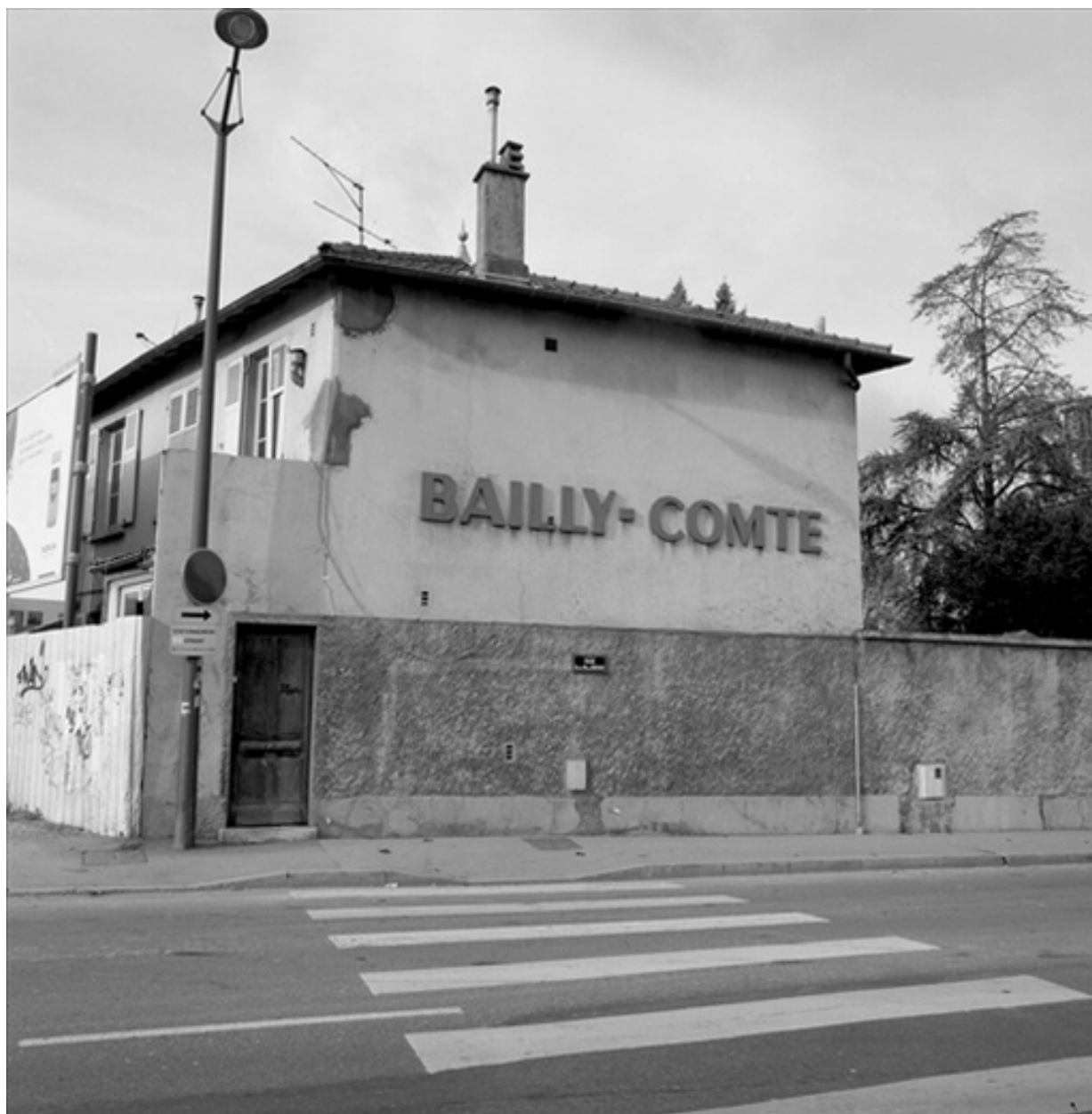
Vue générale, façade est avec enseigne
