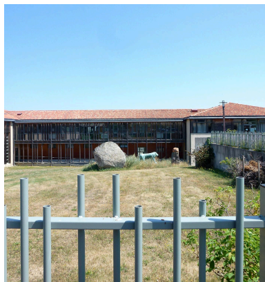
Vue de l'installation dans son environnement, depuis la rue Phot. Bénédicte Renaud-Morand IVR84_20241500145NUCA
