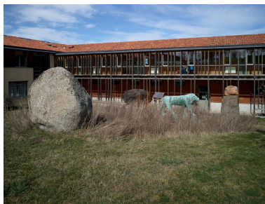
Vue de l'installation dans son environnement, depuis le sud Phot. Christian Parisey IVR84_20241500125NUCA
