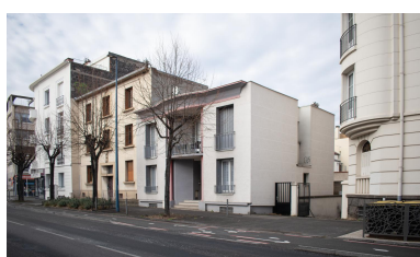
Façades sur le boulevard Jean- Jaurès. Étagement des volumes. Phot. Félicie Fougère IVR84_20256300240NUCA
