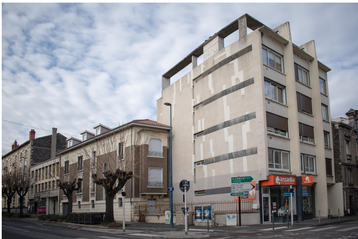
Angle du boulevard Lavoisier et de l'avenue de la Libération. Mur aveugle et immeuble en fer à repasser.
