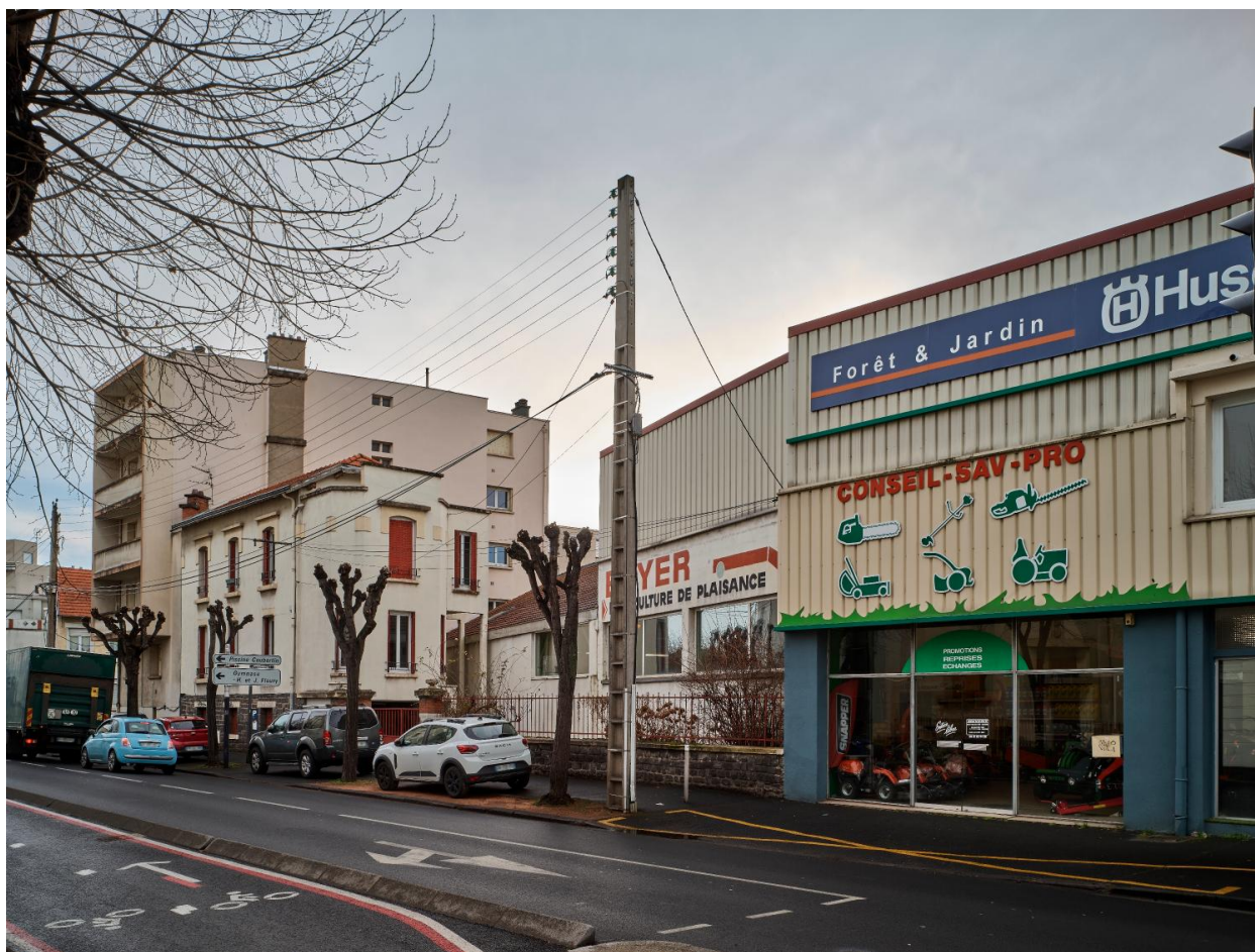
Implantation latérale au boulevard et cour de séparation avec le commerce voisin
