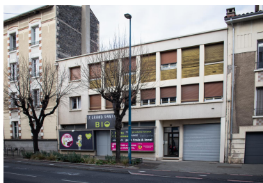
Façade sur le boulevard Jean- Jaurès (Douat, architecte, 1961) Phot. Félicie Fougère IVR84_20256300230NUCA
