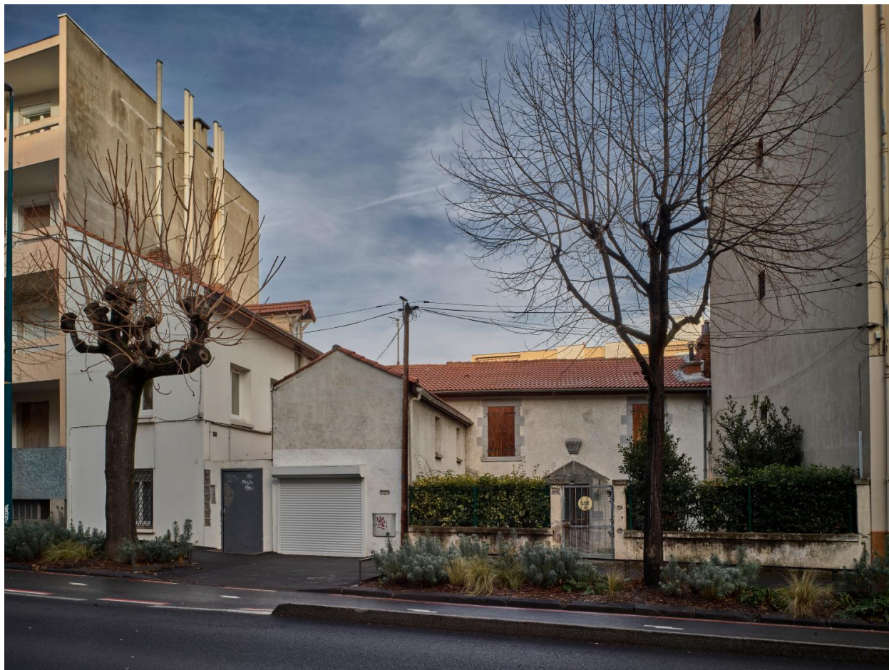
Façade en retrait du boulevard Jean-Jaurès, élévation du garage et immeubles voisins. Etagement des volumes.
