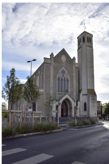
Façade sur la place Littre Phot. Félicie Fougère IVR84_20256300178NUCA
