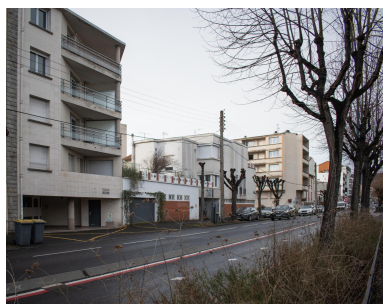
Rive du boulevard Jean- Jaurès avant le carrefour avec le boulevard Jean-Jaurès Phot. Félicie Fougère IVR84_20256300405NUCA
