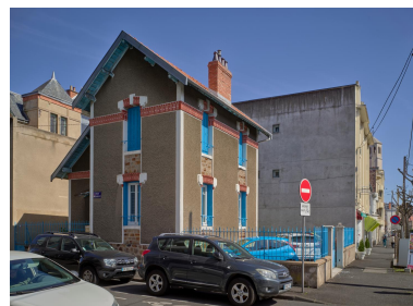
Façade et jardin latéral Phot. Christian Parisey IVR84_20236300396NUC4A
