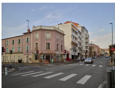
Façades sur le boulevard Jean-Jaurès, carrefour avec l'avenue de la Libération Phot. Christian Parisey IVR84_20236300341NUC4A
