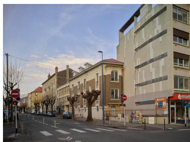
Elévation aveugle et immeuble en fer à repasser Phot. Christian Parisey IVR84_20236300343NUC4A
