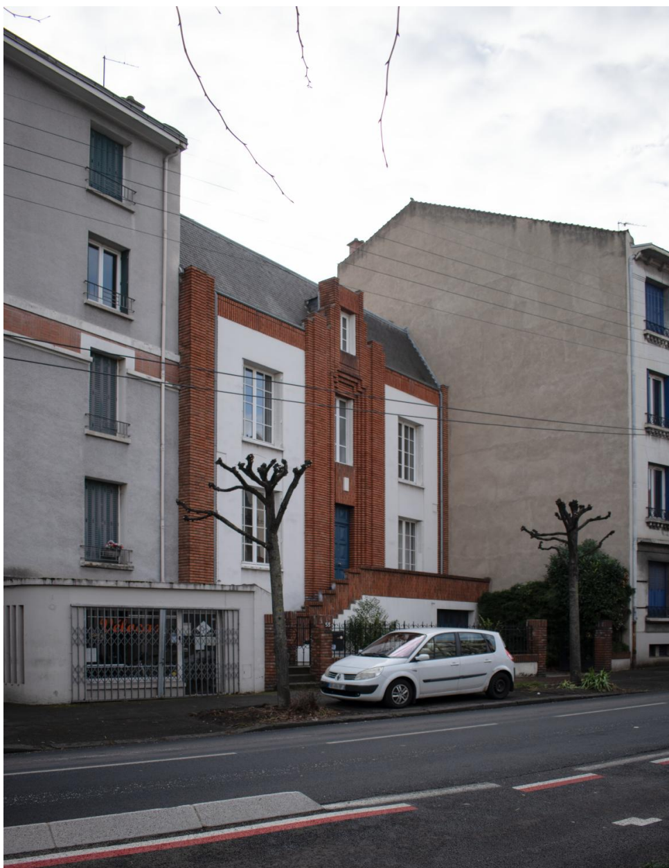
Pignon d'alignement sur le boulevard Jean-Jaurès
