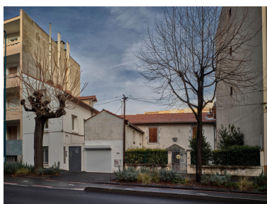
Façade en retrait du boulevard Jean-Jaurès, élévation du garage et immeubles voisins. Étagement des volumes. Phot. Christian Parisey IVR84_20256300304NUCA
